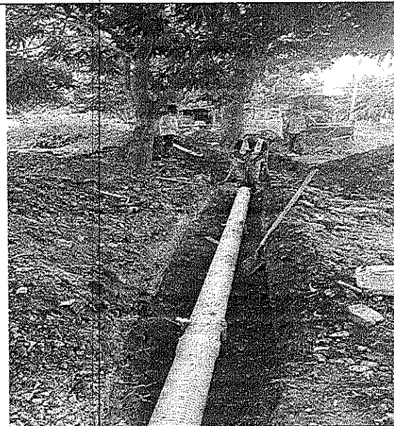
Instalacion de alcantarillado., cama de arena.
