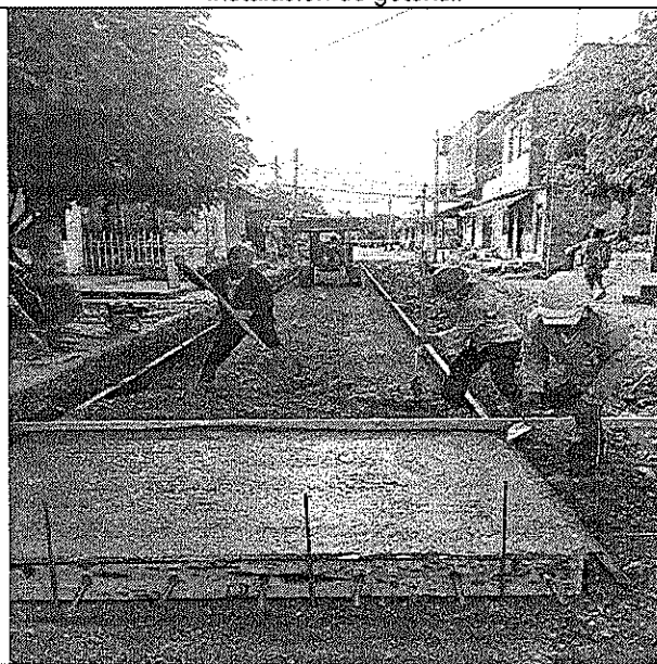
Fundida en concreto.
