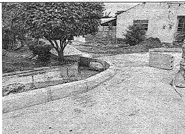
Instalacion de sardinel y fundida de viga en andenes.
