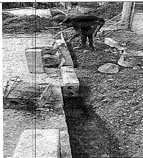
Instalacion de base en concreto y sardinel en andenes.
