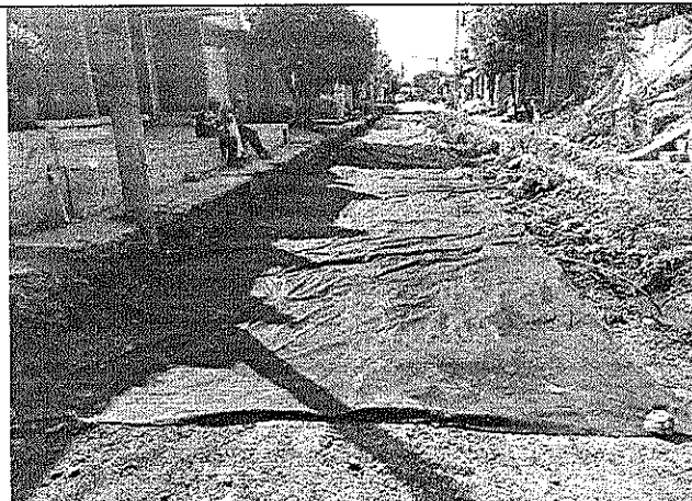
Instalacion de gotextil.
