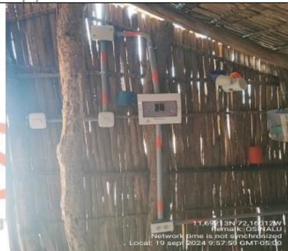
Instalación de circuitos internos
