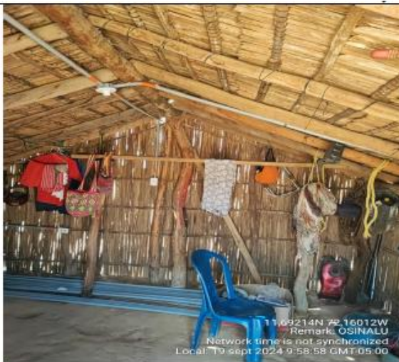
Instalación de circuitos internos
