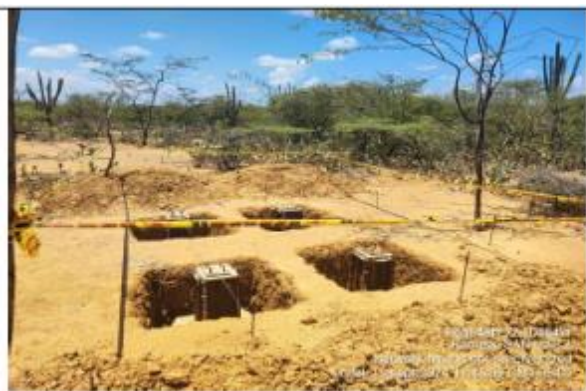
Excavaciones cimentación para nano redes.
