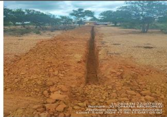
Excavación para red principal
