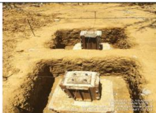
Excavaciones cimentación para nano redes.
