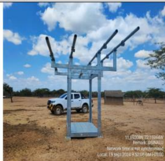
Instalación de estructura para nano redes.
