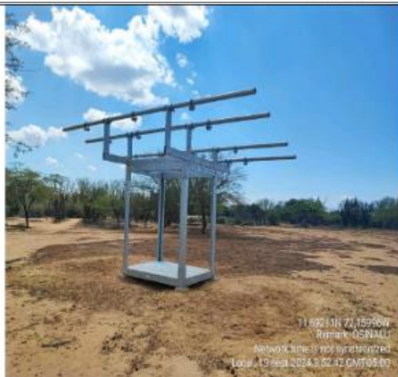
Instalación de estructura para nano redes.
