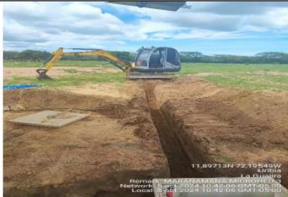
Excavación para red principal
