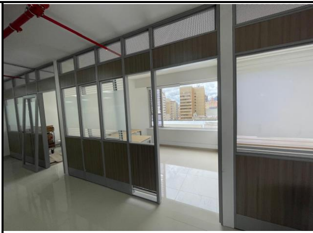
Instalación de divisiones piso techo en el Piso 7 del edificio de la Bolsa
