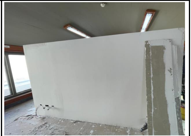
Instalación de divisiones media altura en el Piso 7 del edificio de la Bolsa
