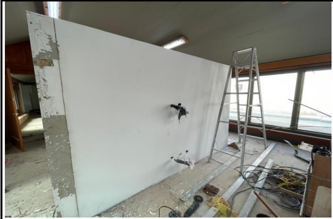
Instalación del muro en Superboard en el cuarto del RACK en el Piso 7 del edificio de la Bolsa
