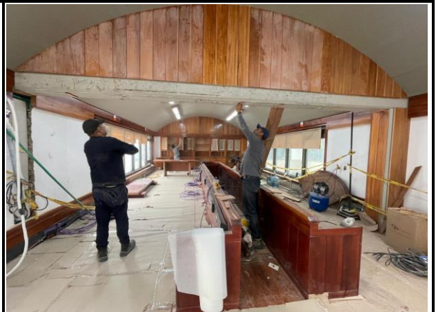
Instalación del muro de superboard en la Comisión Nacional de Disciplina Judicial.
