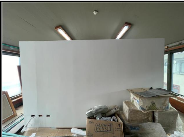
Cambio del muro de superboard debido a que no cumple y esta desplomado en la Comisión Nacional de Disciplina Judicial.
