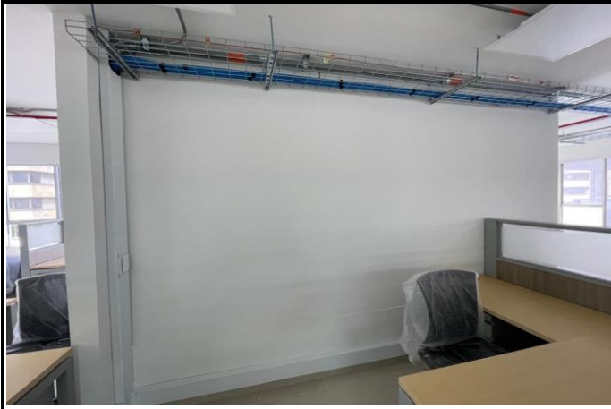
Instalación del muro en Superboard en el cuarto del RACK en el Piso 7 del edificio de la Bolsa
