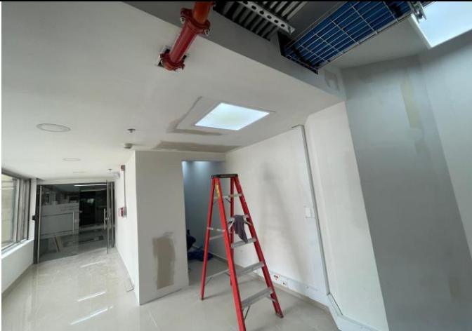
Resane y pintura de muros en el piso 3 del edificio Almacén Calle 18
