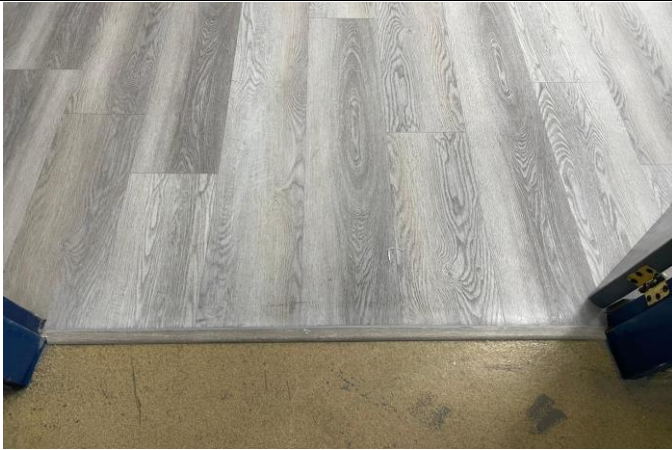
Remate en la instalación del bocel en la oficina de bodega en el piso 1 del edificio Almacén Calle 18
