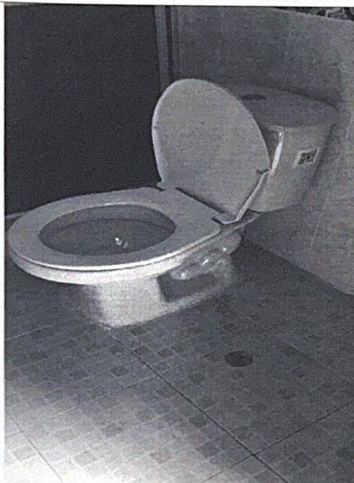
Fotografía 11. Suministro e instalación de sanitarios municipio de La Vega.
