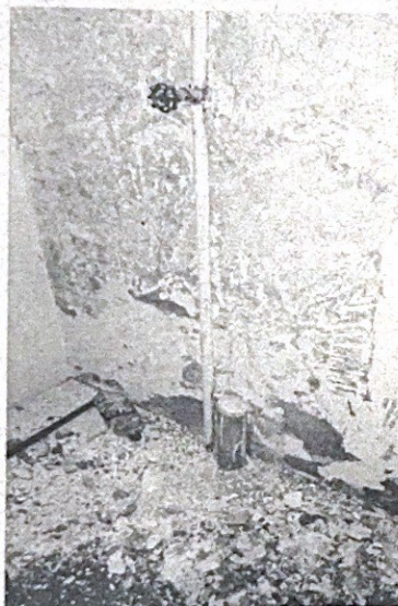
Fotografía 1. Rasqueteo de muros, municipio de La Vega
