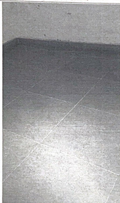
Fotografía 9. Guarda escoba cerámico en el municipio de La Vega.
