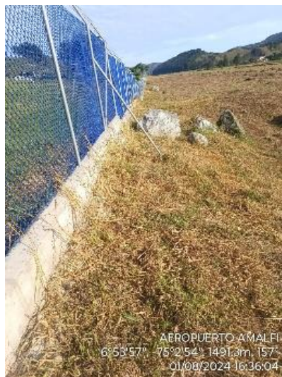
Foto No. 2. CERRAMIENTO AEROPUERTO
