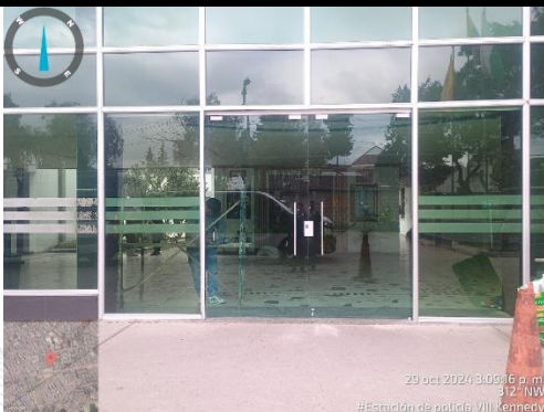
Foto 3. Estación de policía VIII Kennedy. Instalación de puerta en vidrio templado.
