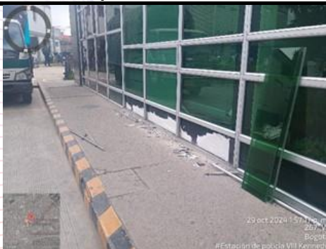
Foto 5. Estación de policía VIII Kennedy. Retiro de vidrios y resanes generales en terminado de fachada.
