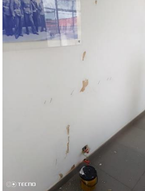
Foto 1. Estación de policía III Santa Fe. Mantenimiento y resanes generales en hall de alojamiento 9 y 10.
