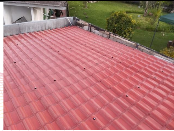
Foto 18. Casa Ambiental. Instalación de cubierta UPVC tipo española.
