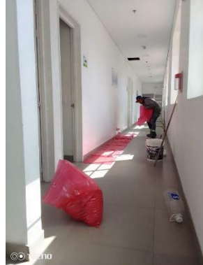
Foto 2. Estación de policía III Santa Fe. Mantenimiento y pintura en hall de alojamiento 9 y 10.
