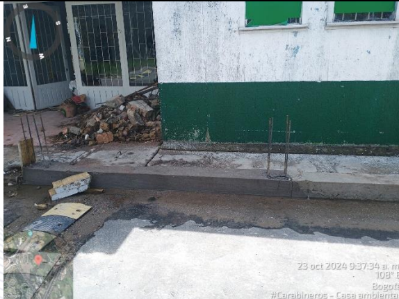
Foto 15. Casa Ambiental. Viga de cimentación para muro de cerramiento.
