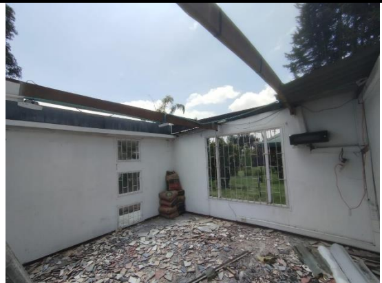
Foto 18. Casa Ambiental. Desmonte de cubierta antigua de Eternit.
