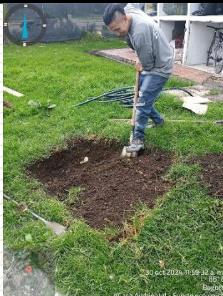
Foto 17. Casa Ambiental. Excavación manual para caja de paso.
