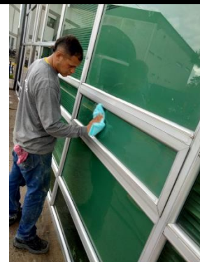
Foto 4. Estación de policía VIII Kennedy. Recorrido y lavado de fachada en aluminio.
