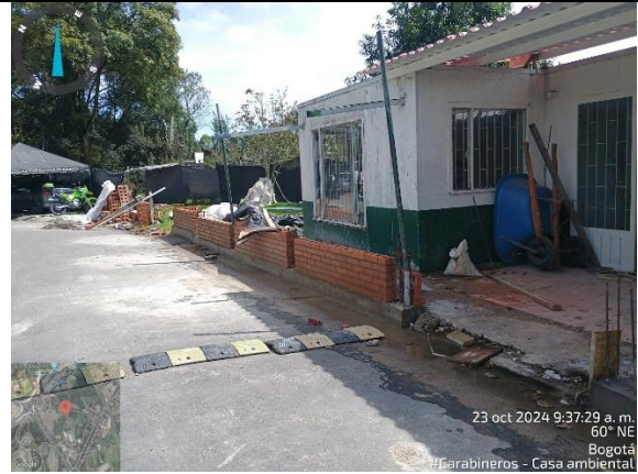
Foto 16. Casa Ambiental. Construcción de muro en ladrillo a la vista de cerramiento.
