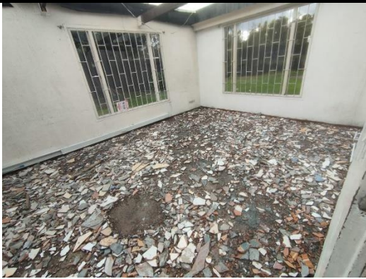
Foto 17. Casa Ambiental. Demolición de enchapes existentes.
