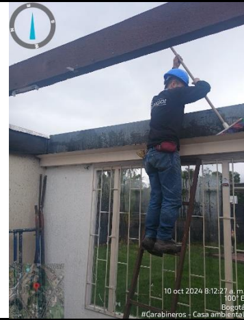
Foto 14. Casa Ambiental. Limpieza de canales metálicas.
