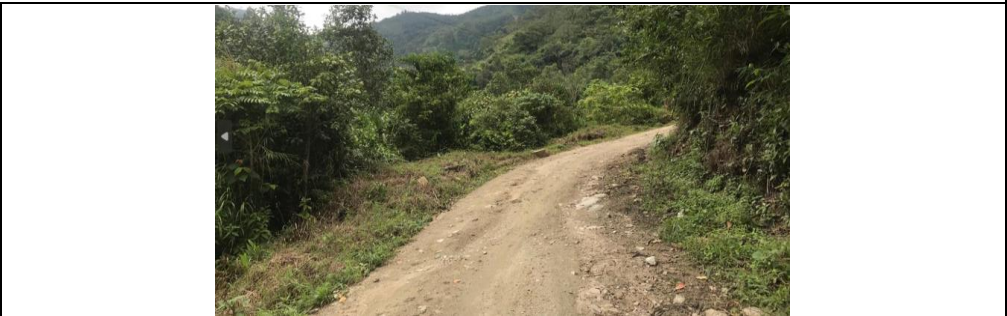
FOTOGRAFIA 2: VIA A INTERVENIR
