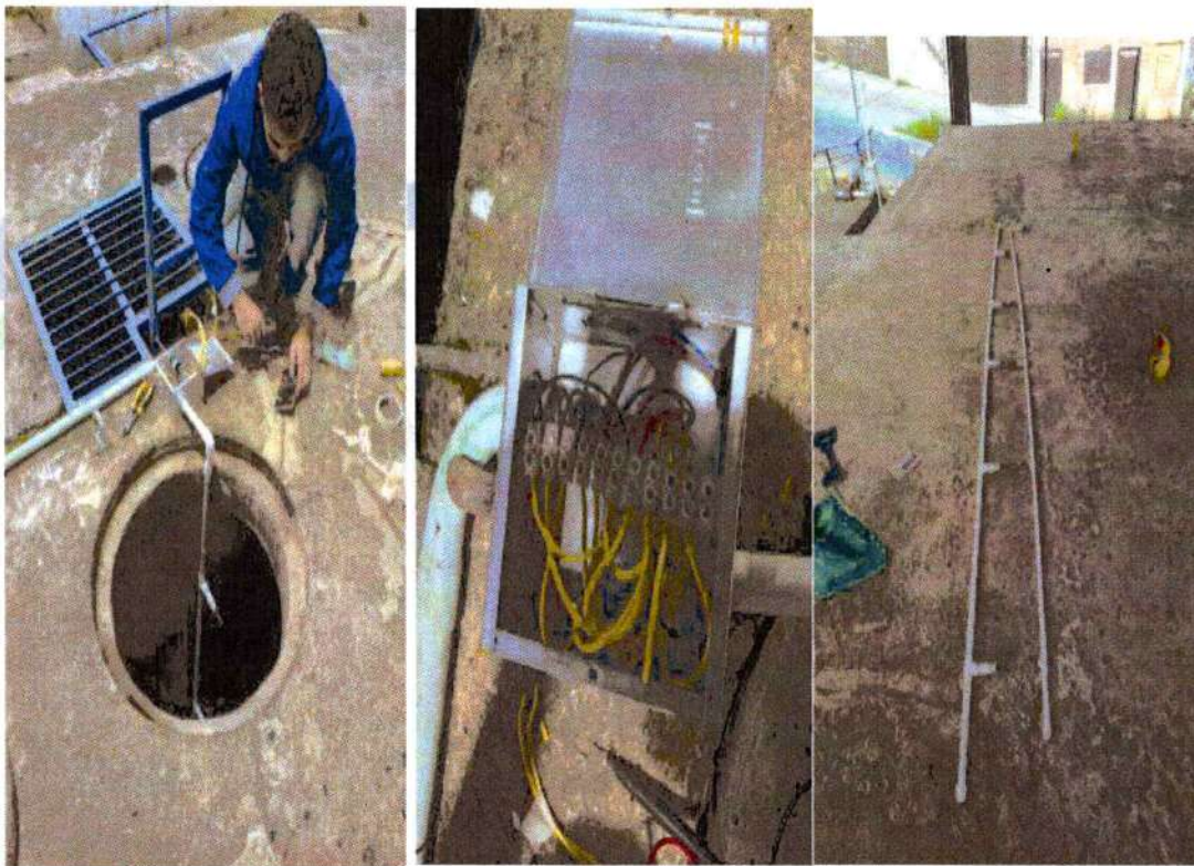
Instalacion barra sensores de nivel PLC
