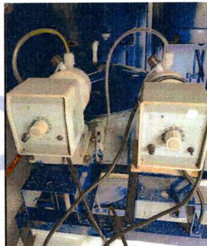
cambio mangera bombas dosificadora
