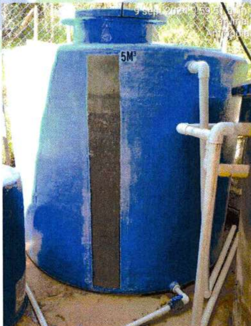
Instalación tanque almacenamiento lixiviados
