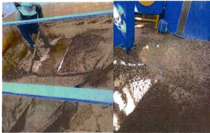
Retiro de material existente
