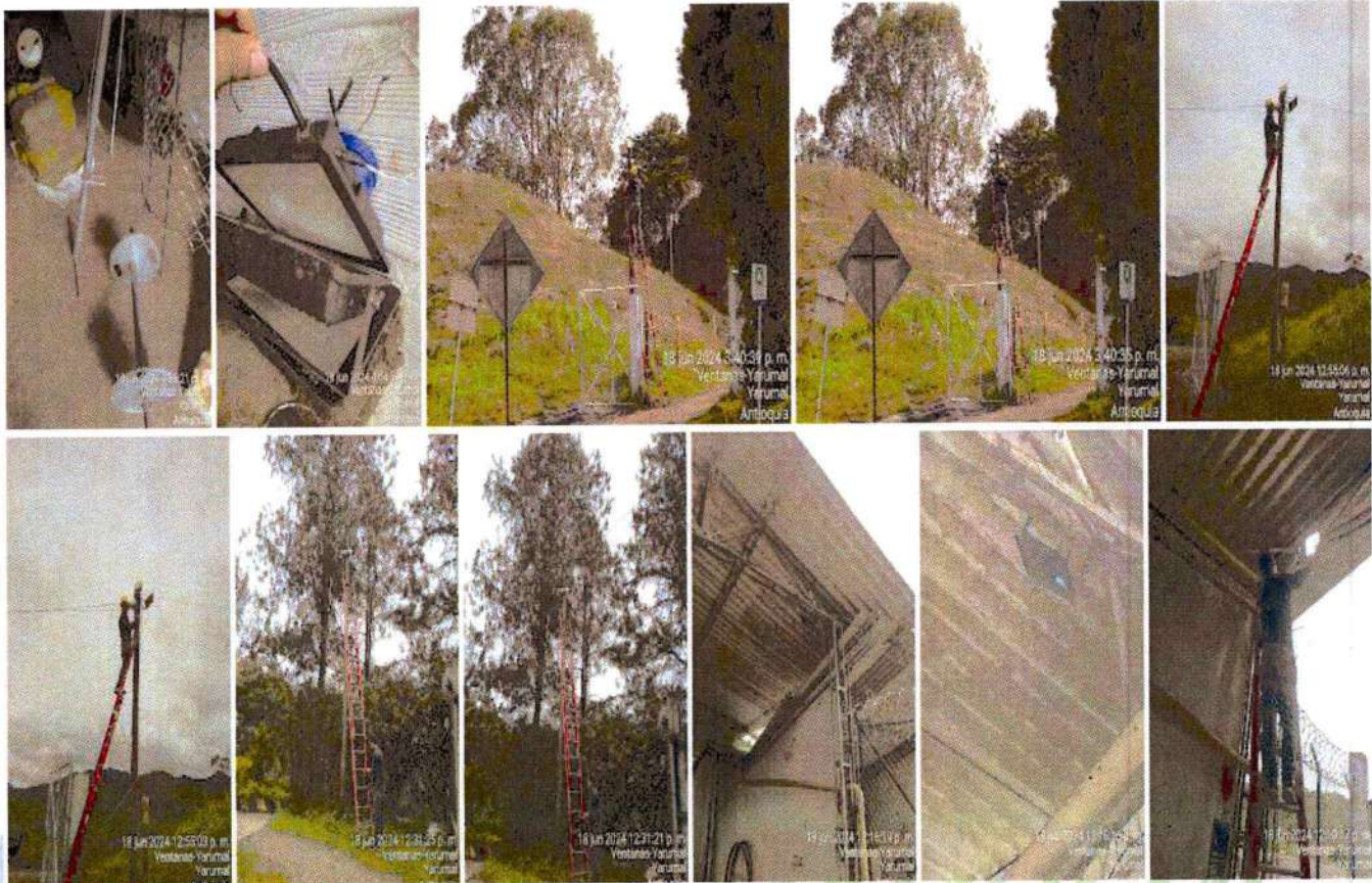
Instalación reflectores relleno sanitario
