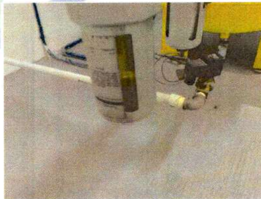
adecuación trampa de grasa
