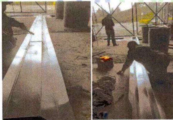
Construcción canoa en lámina
