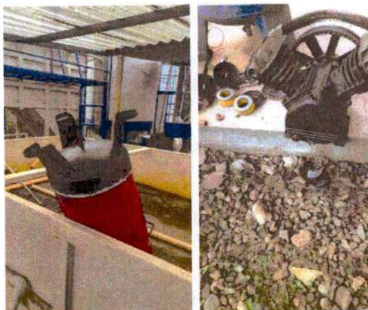
Aplicacion bpdychu anticorrosivo y desmonte del motor
