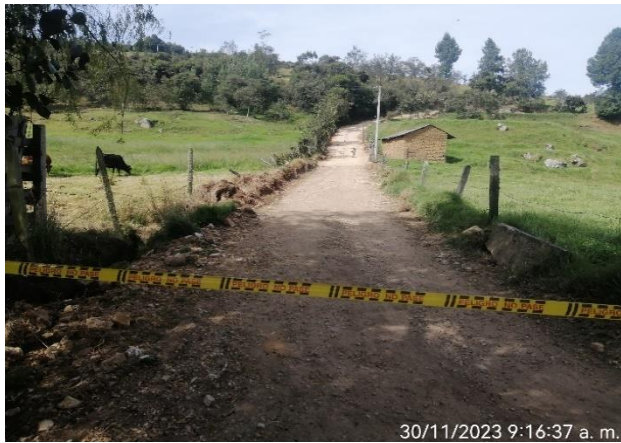
Fotografía No.7. Instalación de cinta de peligro en los frentes de obra.
