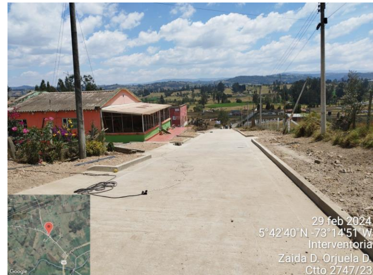
Fotos 23 – 24. CONSTRUCCION PLACA DE CONCRETO RIGIDO Vrd Bosigas “Sotaquirá”
