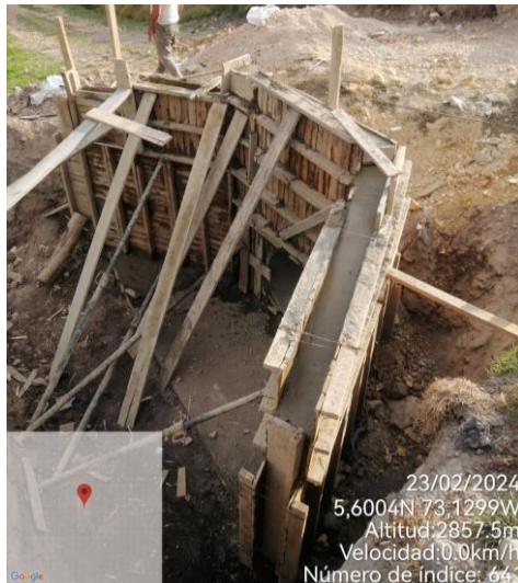
Fotos 9 – 10 CONSTRUCCION ALCANTARILLA TRAMO 2 vrd chorrera “Toca”
