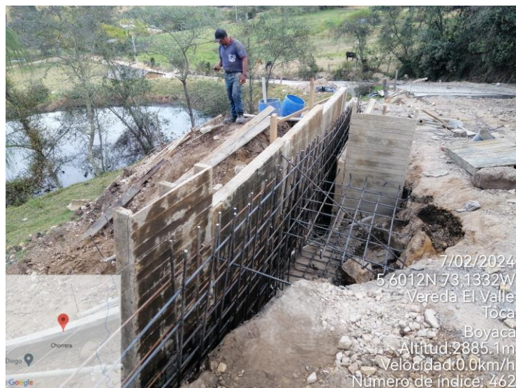
Fotos 19 – 20 CONSTRUCCION DESCOLE ALCANTARILLA TRAMO 1 vrd chorrera “Toca”
