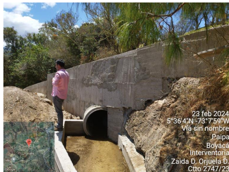
Fotos 19 – 20 CONSTRUCCION DESCOLE ALCANTARILLA TRAMO 1 vrd chorrera “Toca”
