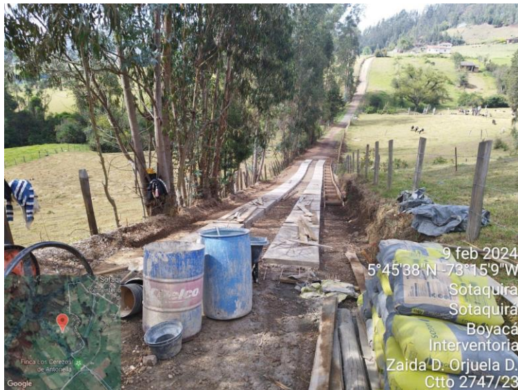
Fotos 13 – 14. construcción placa huella tramo 1 Vrd Chonquirá “Sotaquirá”
