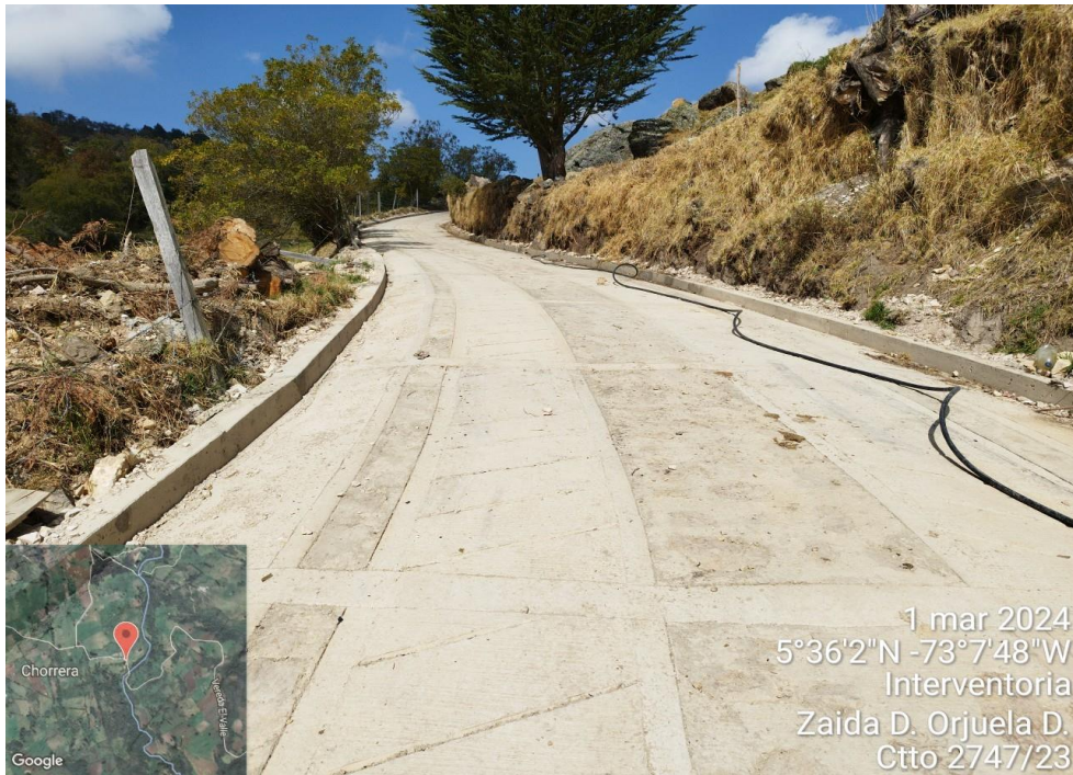
PLACA HUELLA TRAMO 2
