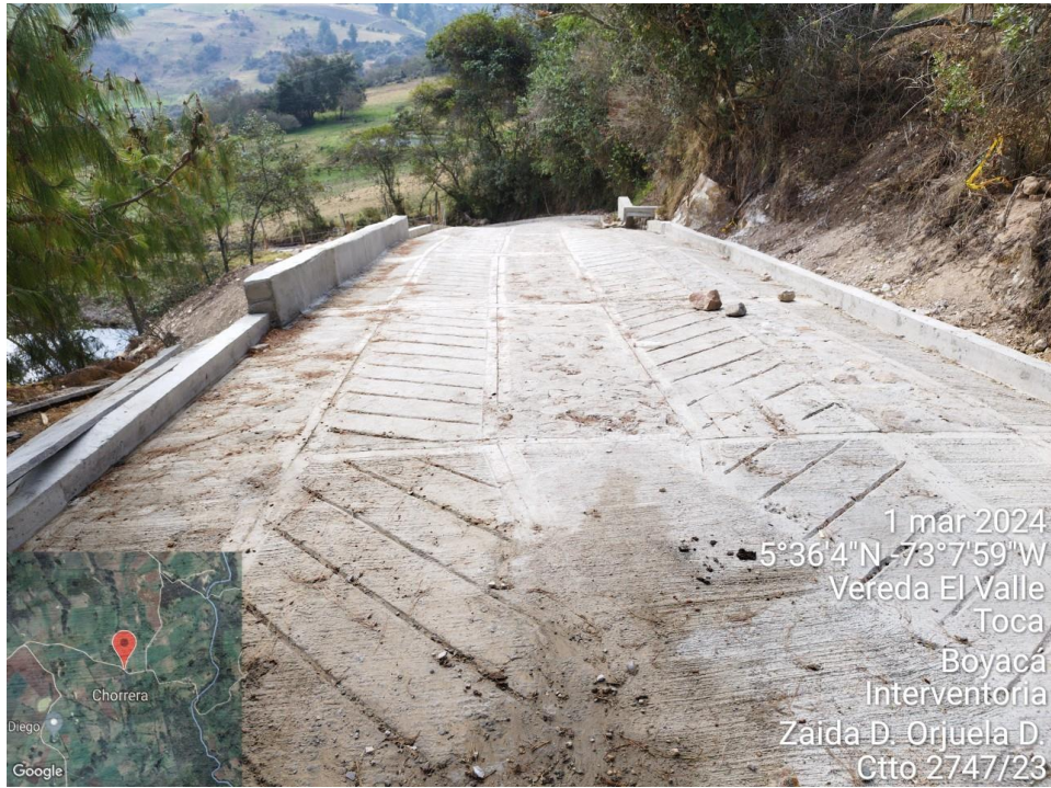
PLACA HUELLA TRAMO 1
