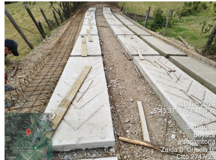
Fotos 13 – 14. construcción placa huella tramo 1 Vrd Chonquirá “Sotaquirá”
