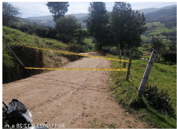
Fotografía No.8. Instalación de cinta de peligro en los frentes de obra.
