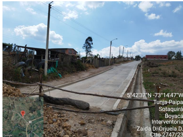
Fotos 23 – 24. CONSTRUCCION PLACA DE CONCRETO RIGIDO Vrd Bosigas “Sotaquirá”
