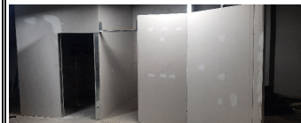
COMENTARIO: Construcción de muros en drywall
