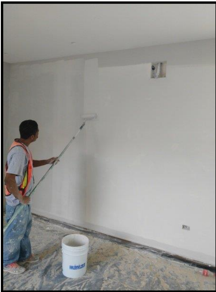
Imagen 11: Pintura Muros con Vinilo Tipo 1.
