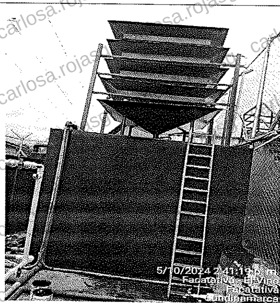
Mantenimiento de Bandejas de Aireación
