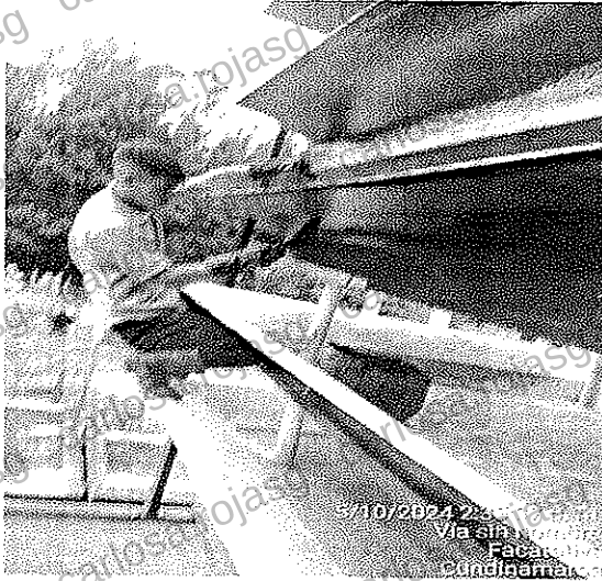
Mantenimiento de Bandejas de Aireación
