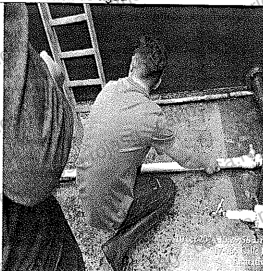
Arreglo de redes hidráulicas de la PTAP
