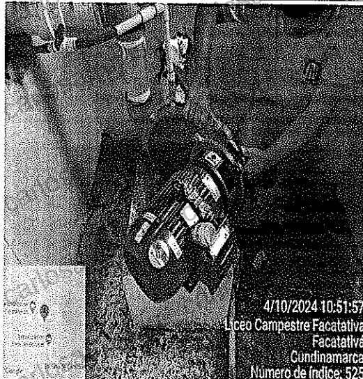
Mantenimiento de bomba de succión de agua
