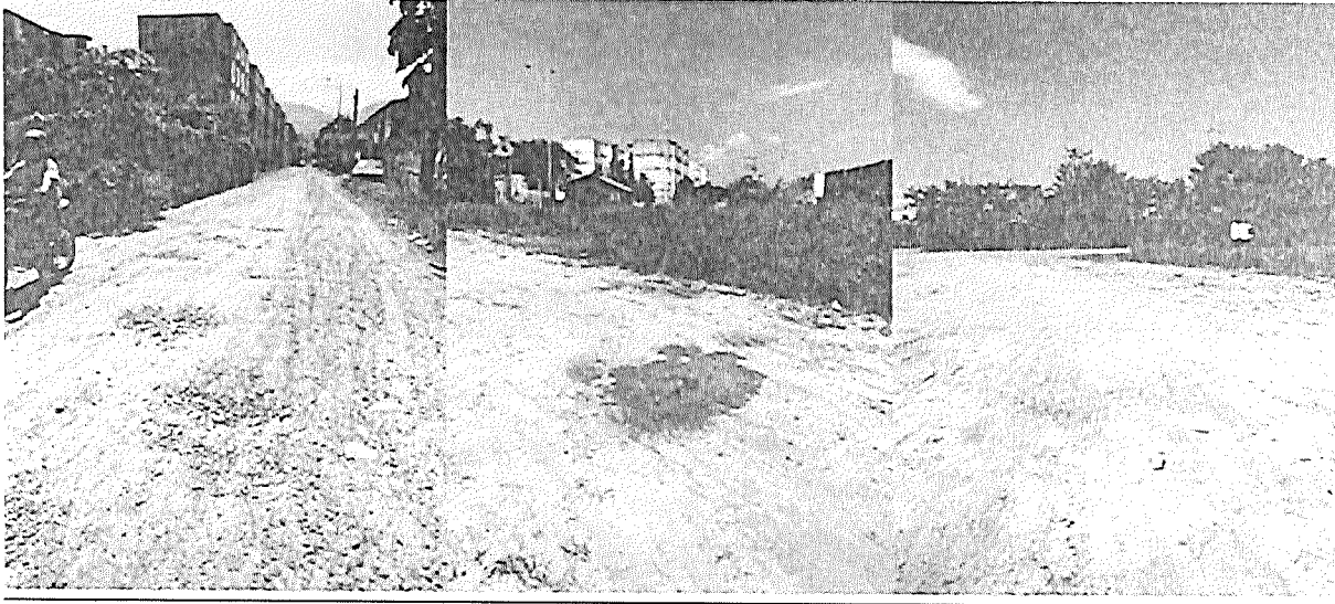
Figura 12: Registro fotográfico estado actual vía de la Calle Principal Torres del Silencio
