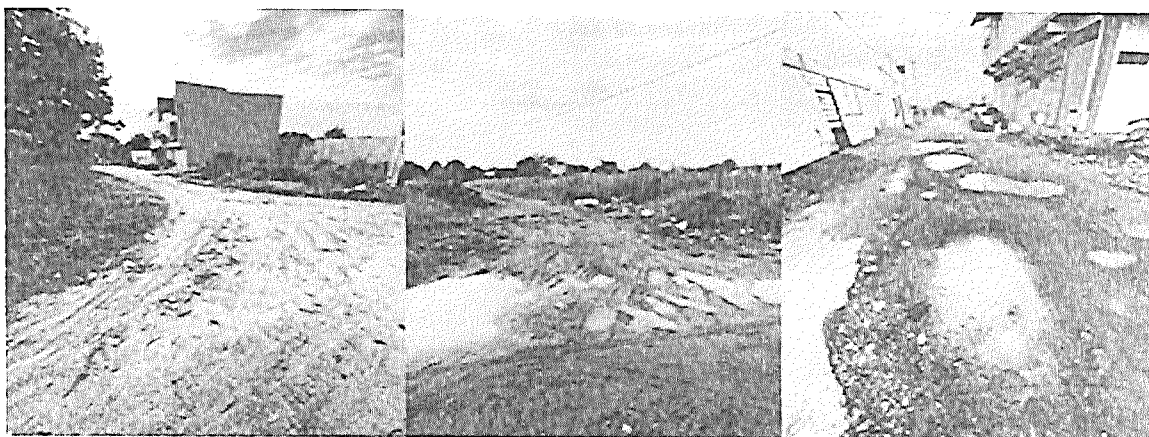
Figura 19: Registro fotográfico estado actual vía internas del barrio cubarrito
