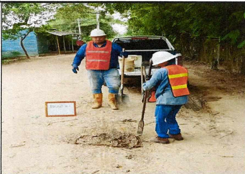
SE UBICA EL APIQUE CON LAS COORDENADAS Y SE HACE LA EXCAVACIÓN MANUAL, SE UTILIZA LA PALA Y LA BARRA DE 16 LIBRAS. SE DEJA EL SITIO FIRME Y NIVELADO, PARA COLOCAR EL CILINDRO A 0,25 METROS.
