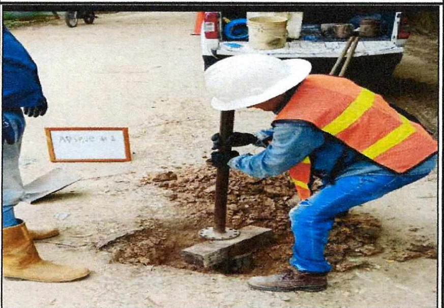
SE ESTÁ SACANDO EL CILINDRO CON LA MUESTRA DEL APIQUE No.2, SE CONTINÚA LA EXCAVACIÓN HASTA 1,56 METROS DE PROFUNDIDAD. NIVEL FREÁTICO SE ENCONTRÓ A 1,62 METROS, NÚMERO DE MUESTRAS TRES (3). SE LLEVA AL LABORATORIO, PARA HACER LOS ENSAYOS .
