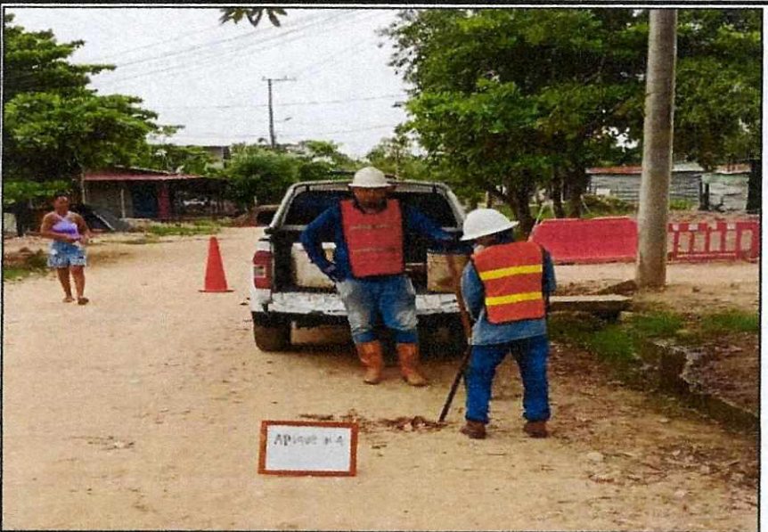
LA EXCAVACIÓN MANUAL DEL APIQUE No.4, LA REALIZAN LOS TRABAJADORES UTILIZANDO UNA BARRA DE 16 LIBRAS, UNA GARLANCHA PARA SACAR EL MATERIAL EXCAVADO. SE DEJA LA BASE PLANA DONDE SE VA A COLOCAR EL CILINDRO TOMA MUESTRA, PROFUNDIDAD PARA COLOCAR EL CILINDRO A 0,30 METROS.PARA OBTENER EL MATERIAL PARA EL CBR.
