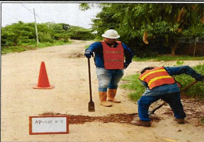
TRABAJADORES REALIZAN LA EXCAVACIÓN MANUAL Y SE UTILIZA LA HERRAMIENTA APROPIADA PARA ESTA ACTIVIDAD. APIQUE No.3.(GARLANCHA, BARRA DE 16 LIBRAS).
