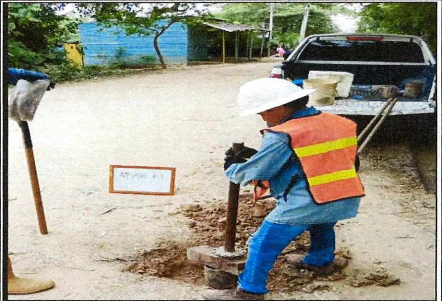
APIQUE No.2, SE GOLPEA AL MADERO CON EL MAZO PARA QUE EL CILINDRO VAYA PENETRANDO Y SE LLENE. SE EXCAVA EL CILINDRO POR LA PARTE EXTERIOR Y SE RETIRA EL CILINDRO DEL APIQUE No.2.
