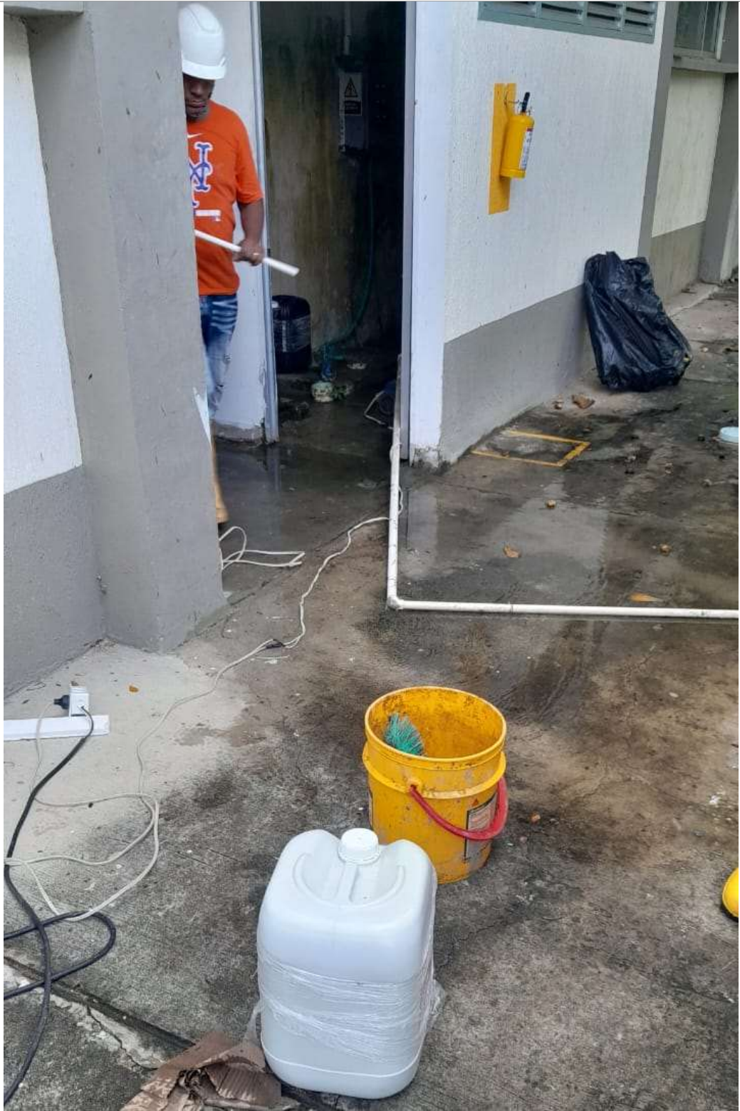
Limpieza y desinfección de tanques subterráneos para el almacenamiento de agua potable al interior del CACOM-3
