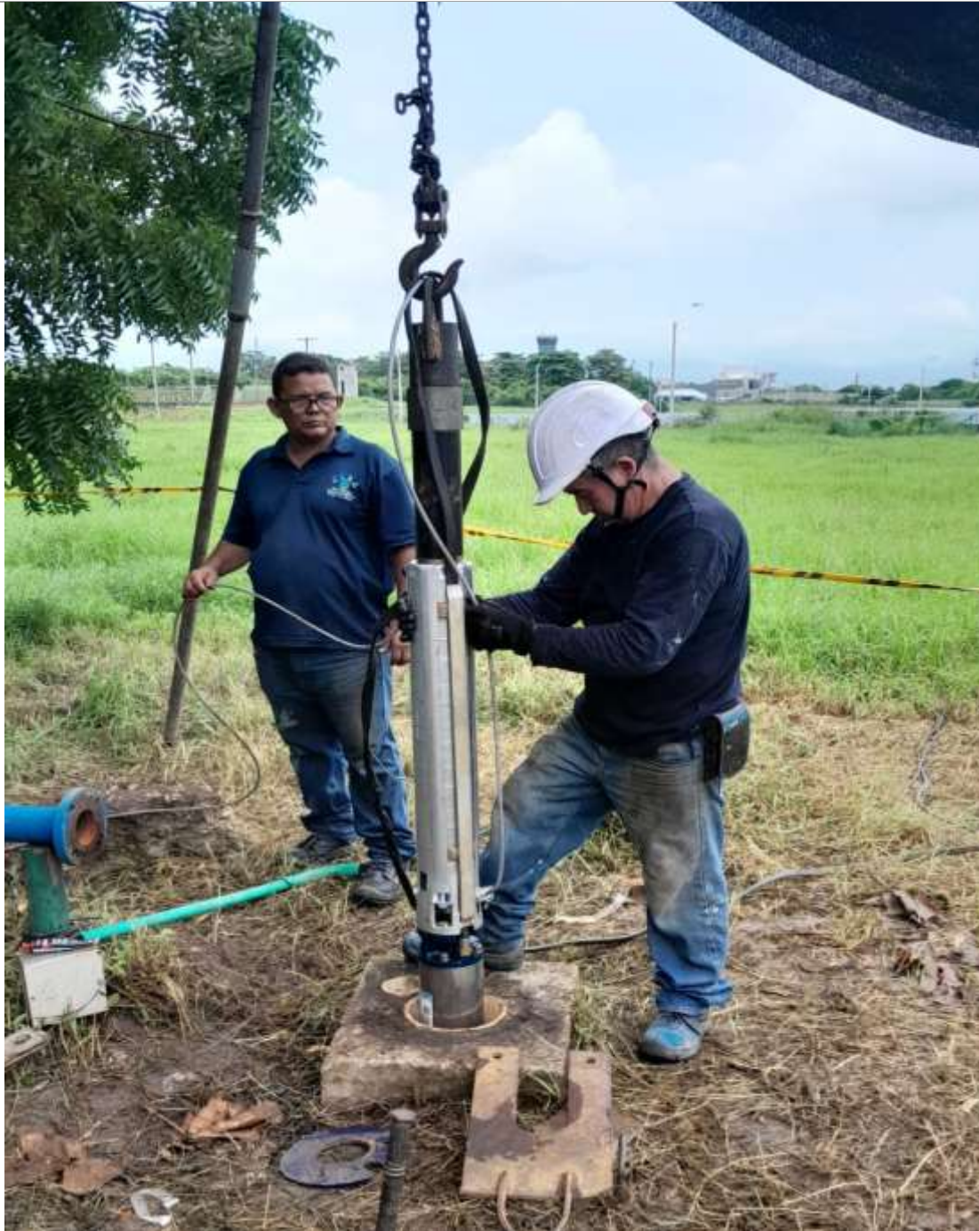
Fotografía Cambio electrobomba tipo lapicero de acuerdo a ficha técnica
