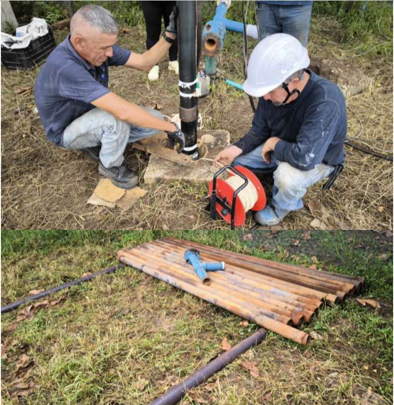
Fotografía Cambio de tubería pozo profundo Dragoncitos
