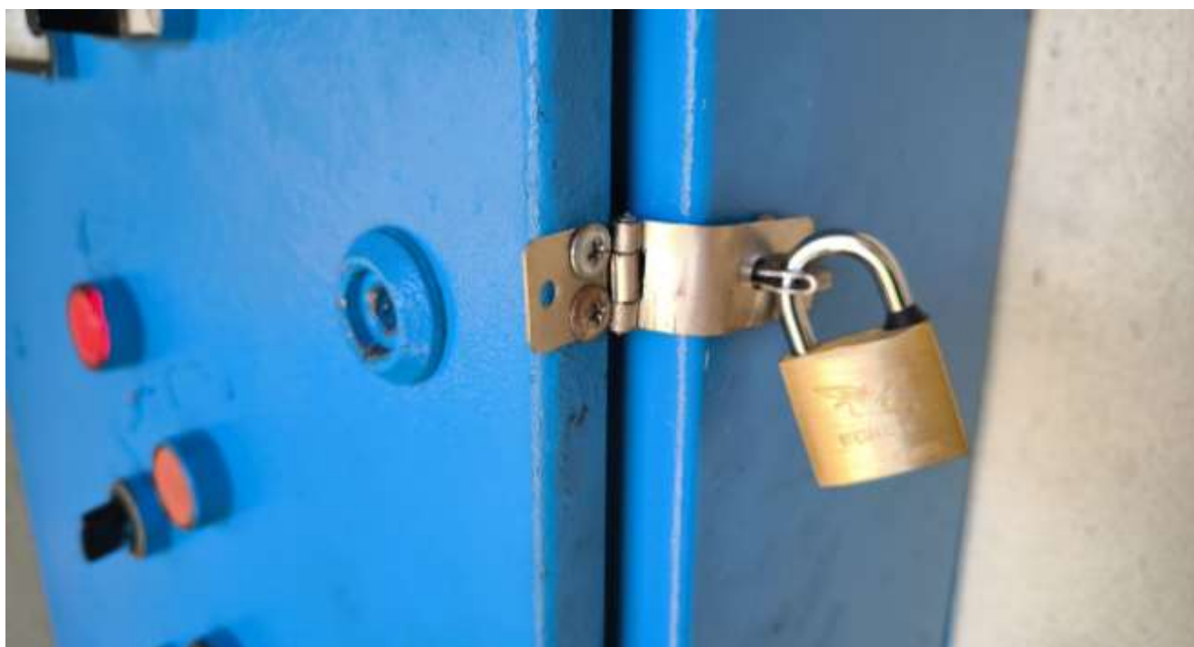
Adecuación seguridad del tablero de control
