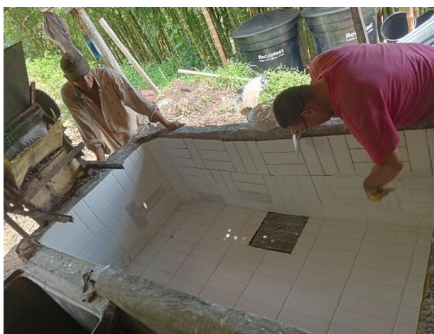
Dotación de tanque tina de 630 litros complementario y adecuación tanque existente con enchape en azulejo.
