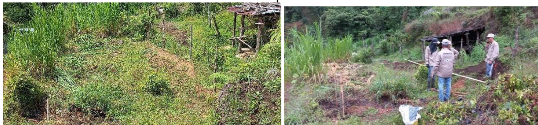
Sitio antes de la instalación e inicio de obra.
