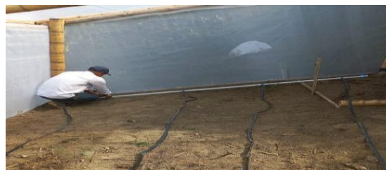
Ilustración 4 Instalación líneas de riego goteo predios El Porvenir y La Chiquita
