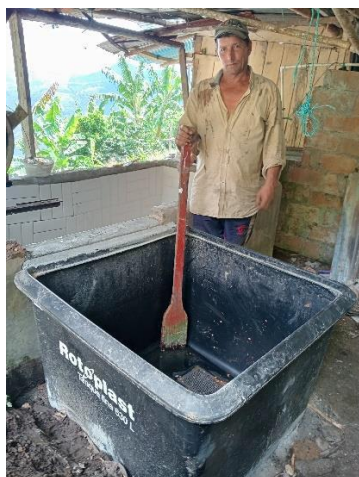
Dotación de tanque tina de 630 litros complementario y adecuación tanque existente con enchape en azulejo.
