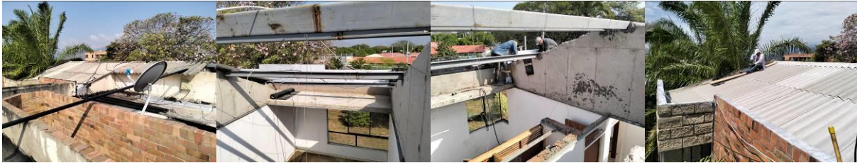
Imagen No. 13 – Instalación de estructura perfil rectangular, accesorios en acero A-36, anclaje epóxico de ½" y mortero 1:4 para cubrimiento de ondulaciones de la teja en el perímetro de la cubierta.
