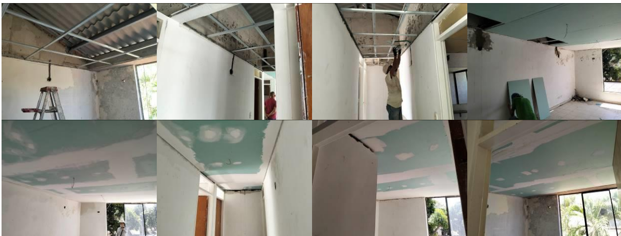
Imagen No. 11 – Instalación de estructura y lámina y aplicación de primera capa de acabado en cielo raso.
