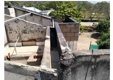
Impermeabilización de viga canal con manto asfáltico y pintura en aluminio.
