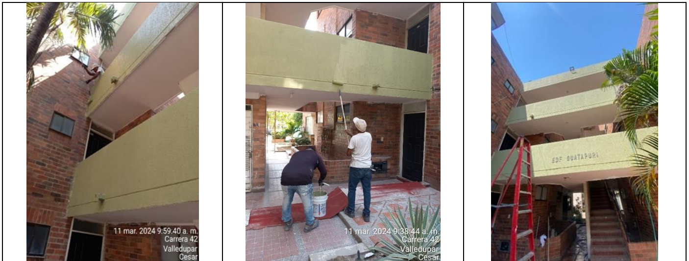
Aplicación de pintura exterior en fachada y zonas comunes del edificio.
