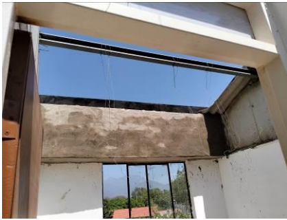
Aplicación de pañete 1:4 en muros y bajo placa interiores en cocina, hall y habitaciones.
