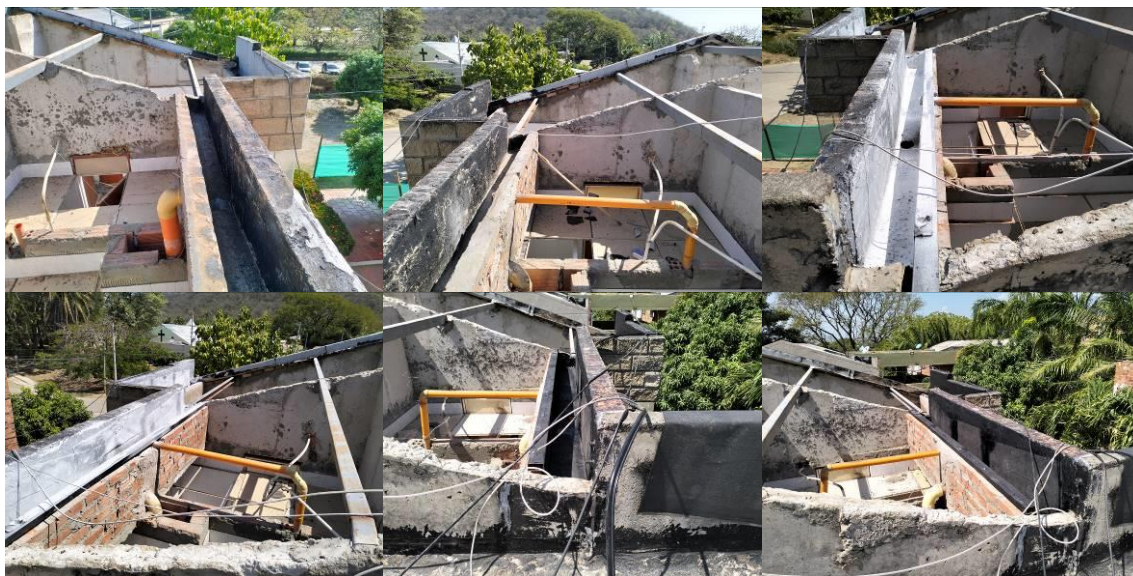
Imagen No. 6 – Instalación de salida de desagüe.
