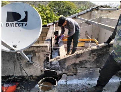
Impermeabilización de viga canal con manto asfáltico y pintura en aluminio.
