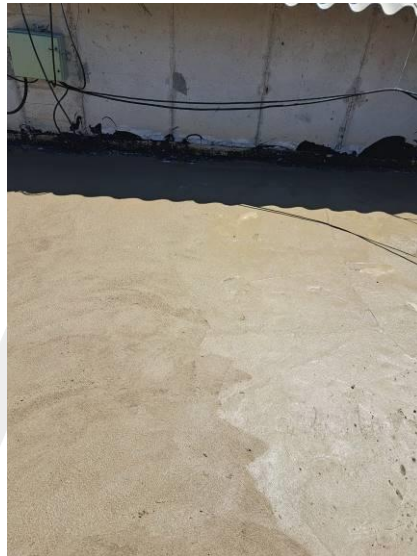
Alistado y nivelación de pisos en placa de cubierta.
