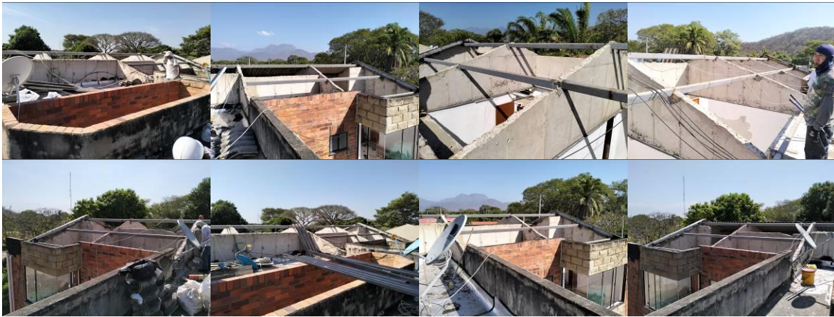
Imagen No. 4 – Desmonte de teja en cubierta.
