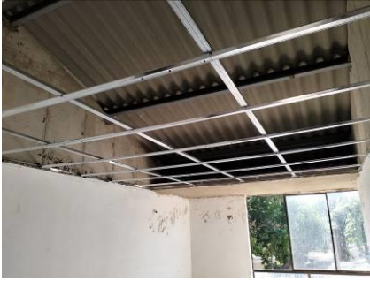
Suministro e instalación de estructura y lámina de cielo raso y enmasillado.
