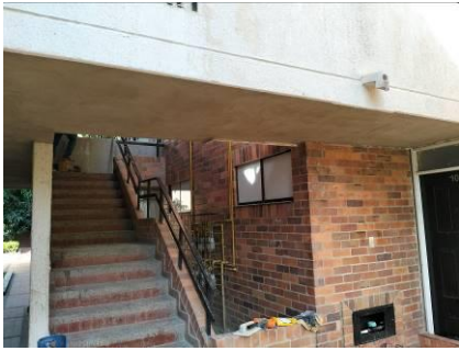
Aplicación de pañete con mortero 1:4 impermeabilizado bajo placa de zonas comunes.
