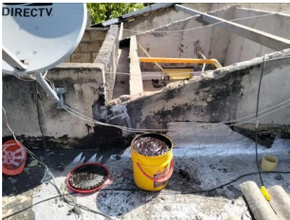
Impermeabilización de viga canal con manto asfáltico y pintura en aluminio.
