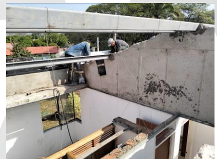
Suministro e instalación de estructura perfil rectangular con anclaje epóxico y accesorios en acero A-36.
