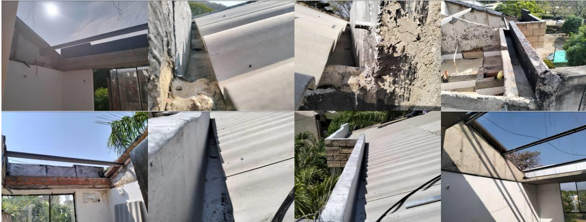
Imagen No. 10 – Impermeabilización de viga canal perimetral en cubierta.
