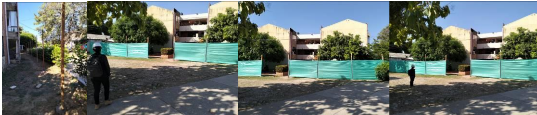
Imagen No. 2 – Cerramiento provisional en polisombra verde.
