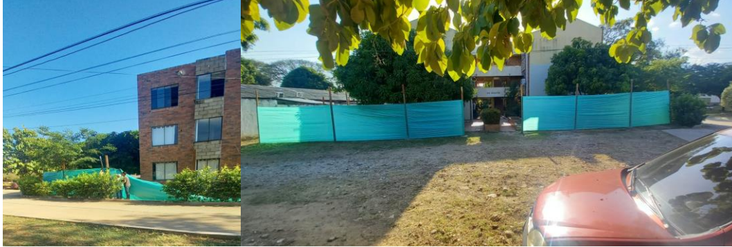
Imagen No. 15 – Cerramiento provisional.
