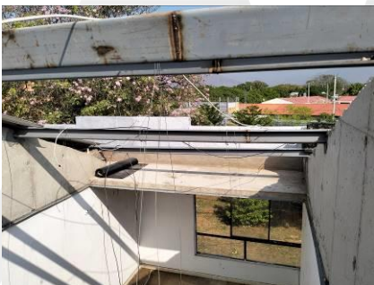
Suministro e instalación de estructura perfil rectangular con anclaje epóxico y accesorios en acero A-36.
