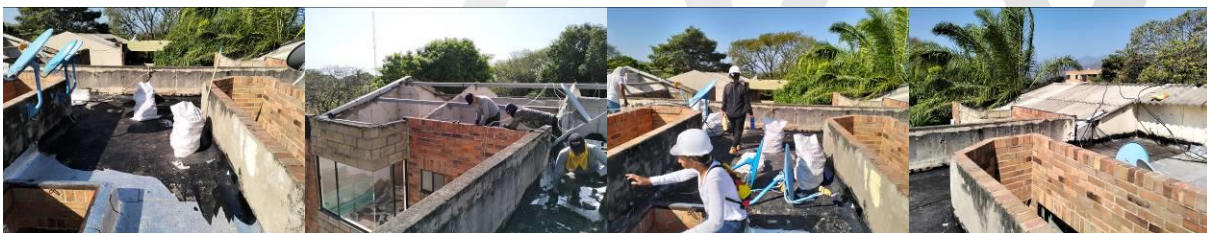
Imagen No. 3 – Demolición de manto existente en cubierta.
