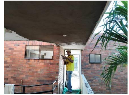
Aplicación de pañete con mortero 1:4 impermeabilizado bajo placa de zonas comunes.
