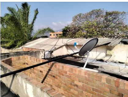
Suministro e instalación de estructura perfil rectangular con anclaje epóxico y accesorios en acero A-36.
