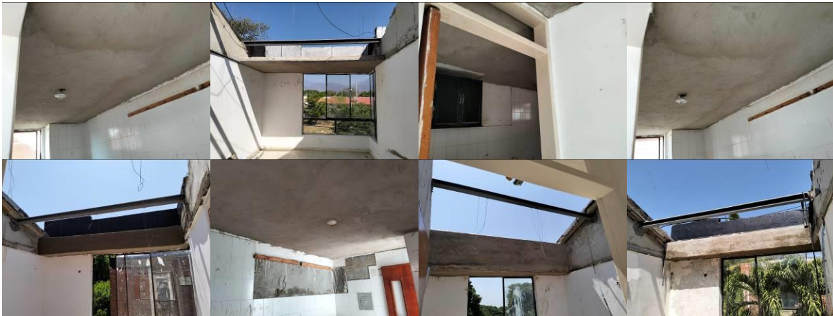
Imagen No. 8 – Pañete liso 1:3 en muros interiores y bajo placa de apartamentos.
