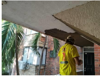
Aplicación de pañete con mortero 1:4 impermeabilizado bajo placa de zonas comunes.
