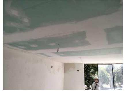
Suministro e instalación de estructura y lámina de cielo raso y enmasillado.
