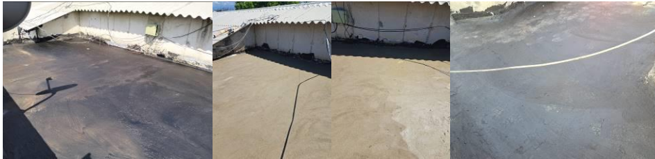
Imagen No. 12 – Alistado y nivelación de pisos mortero 1:4 impermeabilizado en placa de cubierta.
