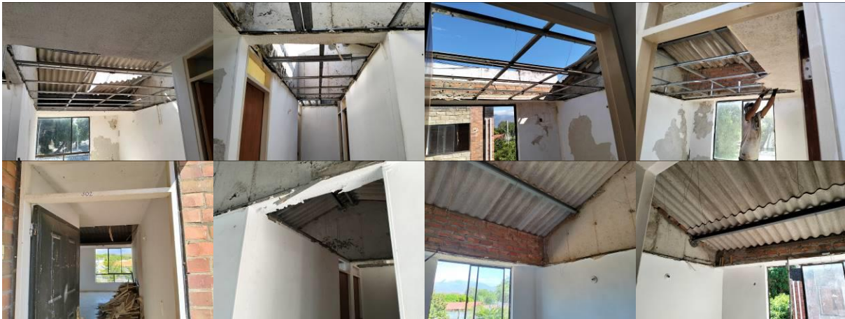
Imagen No. 5 – Desmonte de cielo raso y aparatos eléctricos.
