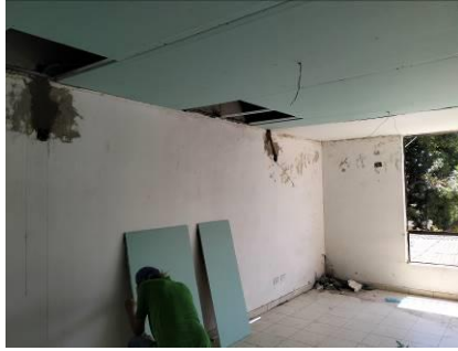
Suministro e instalación de estructura y lámina de cielo raso y enmasillado.
