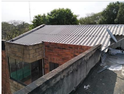
Suministro e instalación de teja y caballete en ambas alas de cubierta.
