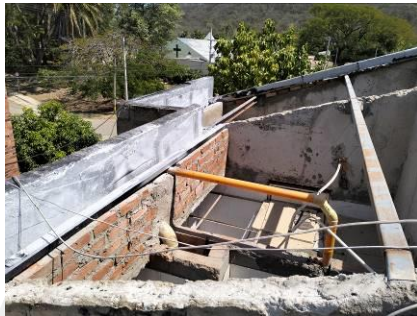
Salida de desagües en tubería PVC sanitaria.
