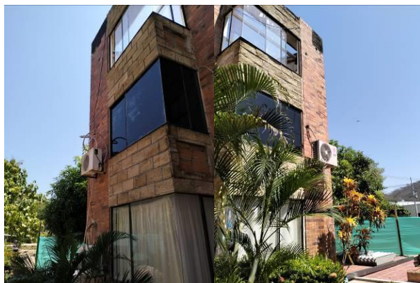
Imagen No. 7 – Desmonte de bajantes de aguas lluvias.
