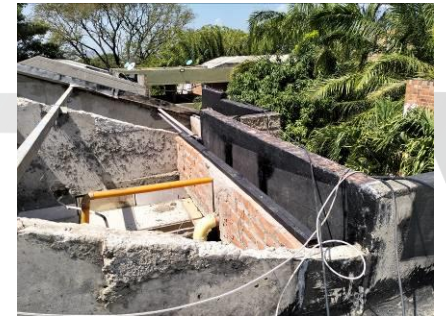
Impermeabilización de viga canal con manto asfáltico y pintura en aluminio.
