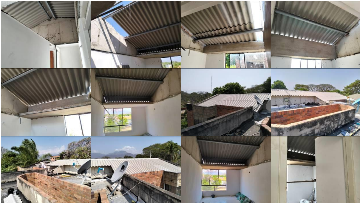
Imagen No. 12 – Alistado y nivelación de pisos mortero 1:4 impermeabilizado en placa de cubierta.
