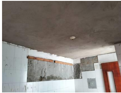
Aplicación de pañete 1:4 en muros y bajo placa interiores en cocina, hall y habitaciones.
