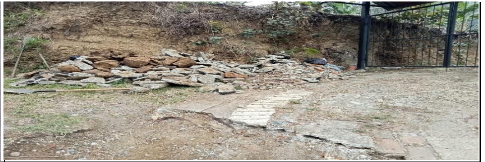
VEREDAD OSPIRMA - DEMOLICION DE HUELLA ESITENTE
