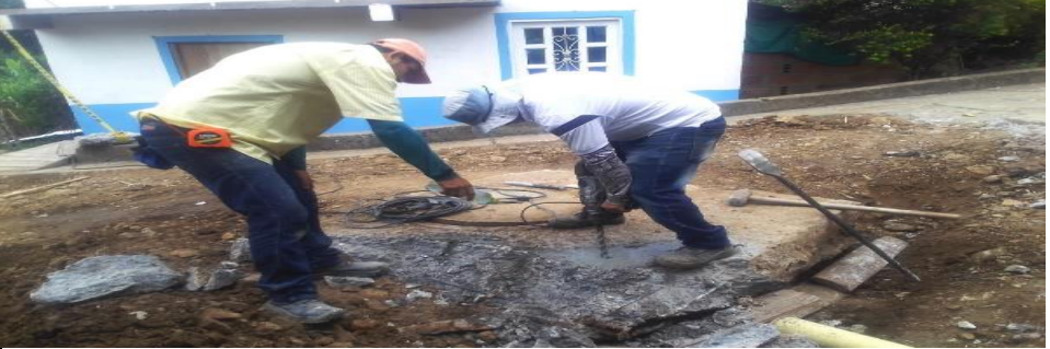
DEMOLICION PLACA DE MH
