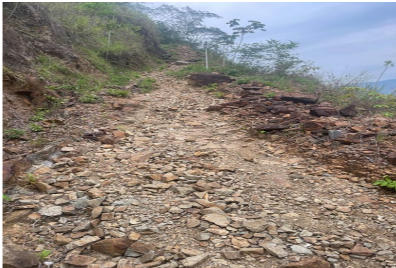
Figura 2. Estado inicial de la vía.
