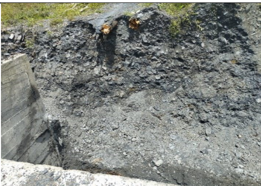
Inicio de excavaciones para la implantación del muro en tierra armada
