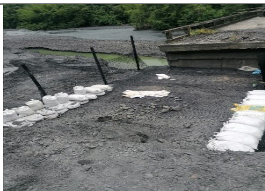
Construcción del muro de tierra armada.
