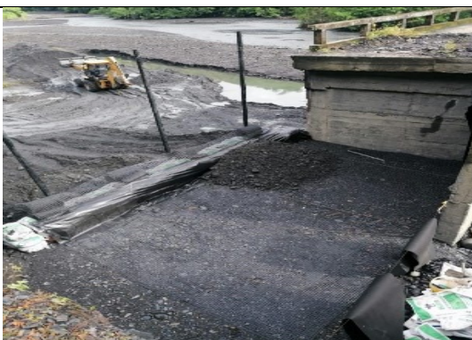
Construcción del muro de tierra armada.
