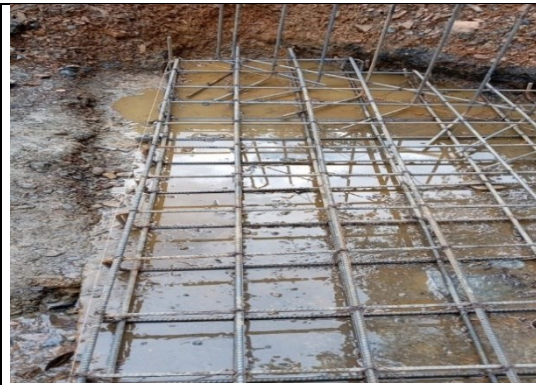
Figurado y amarre de acero de la placa de descole alcantarilla de 36"
