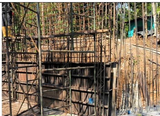
Proceso De Enclavado De Segundo Estribo
