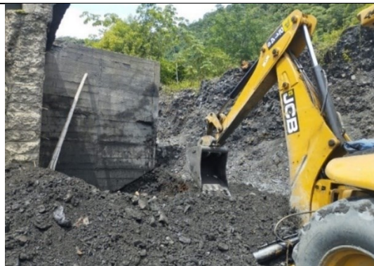
Inicio de excavaciones para la implantación del muro en tierra armada
