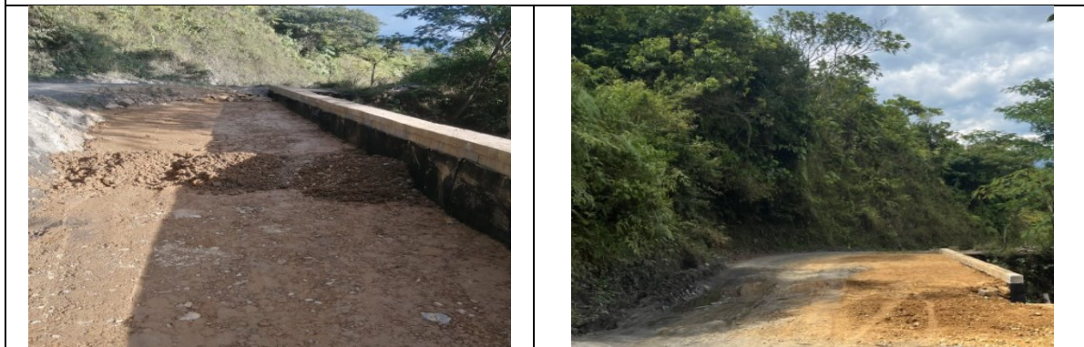
Compactación de base para implementación del Muro de contención.
