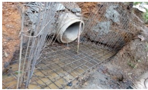
Figurado y amarre de acero de la placa de descole alcantarilla de 36"
