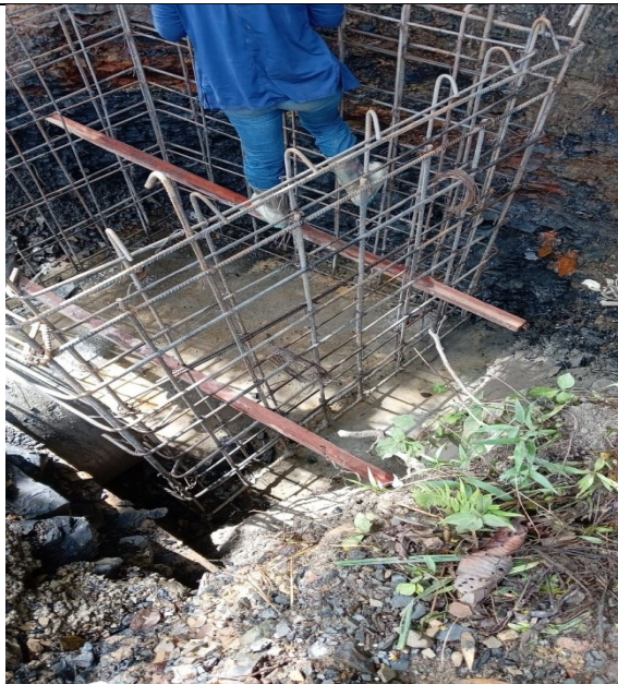
Figurado y amarre de acero de la placa de descole alcantarilla de 36"
