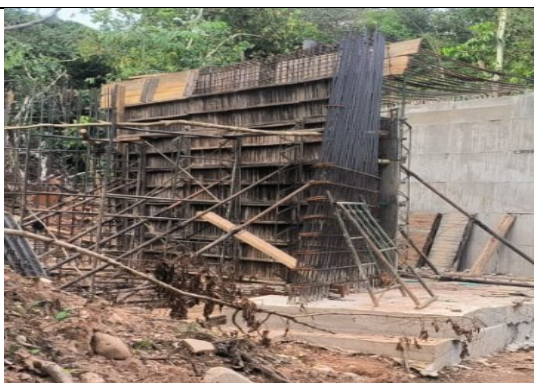
Proceso De Enclavado De Segundo Estribo
