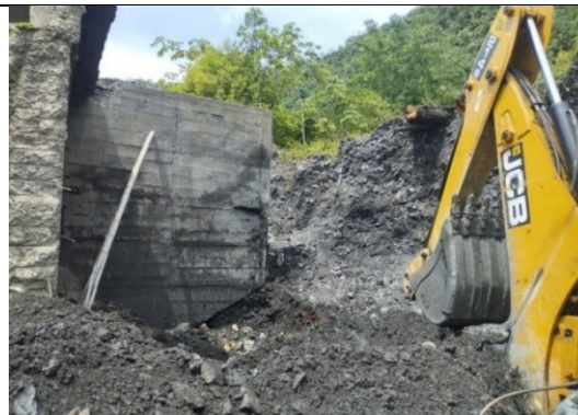
Inicio de excavaciones para la implantación del muro en tierra armada
