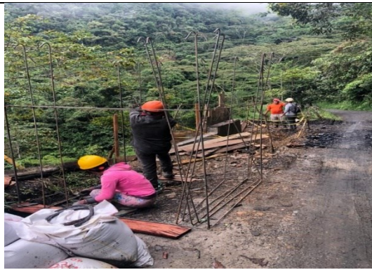
Figurado y amarre de acero de la placa de descole alcantarilla de 36"
