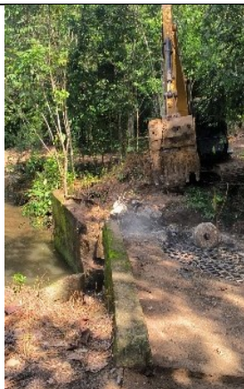
Demolición de la placa existente
