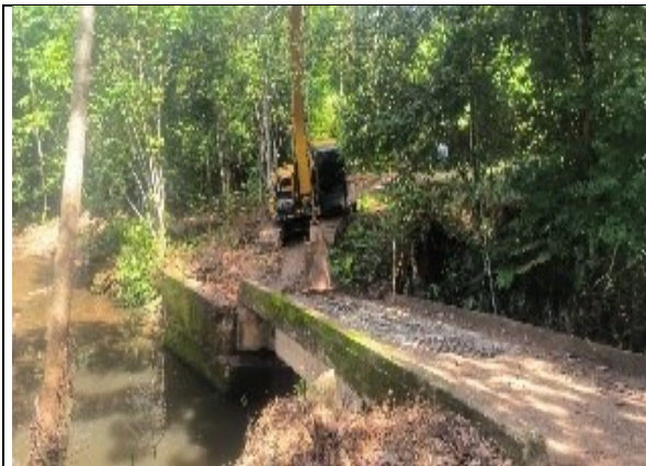
Demolición de la placa existente
