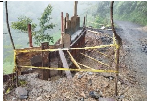
Figurado y amarre de acero de la placa de descole alcantarilla de 36"
