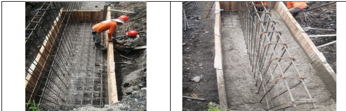
Proceso constructivo del Muro de contención.
