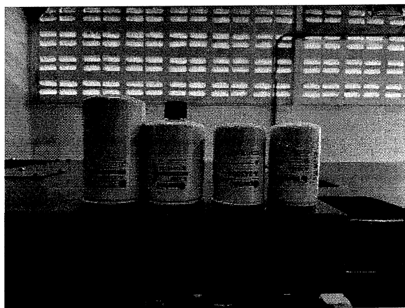
No.002 Cambio de elementos filtrantes a generador ELECTRICO AGG POWER SOLUTION CUMINS modelo C55DA.
