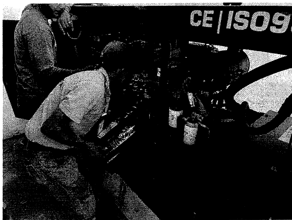
No.001 Cambio de aceite a generador eléctrico AGG POWER SOLUTION CUMINS modelo C55DA.
