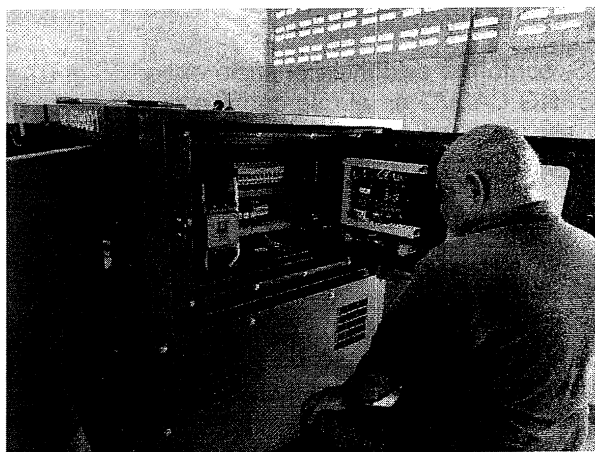
No.003 Comprobación de las protecciones del generador eléctrico AGG POWER SOLUTION CUMINS modelo C55DA.
