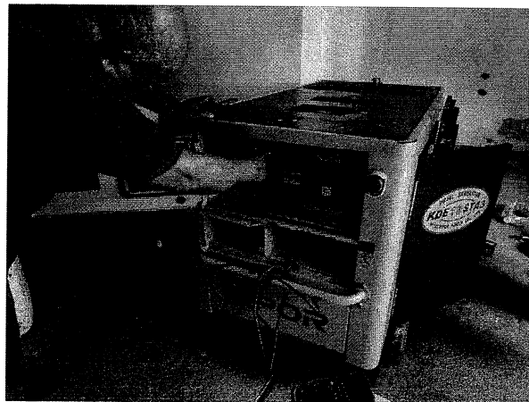
No.009 Comprobación de los parámetros de operación en funcionamiento del generador eléctrico KIMPOR modelo KDE19STA3.
