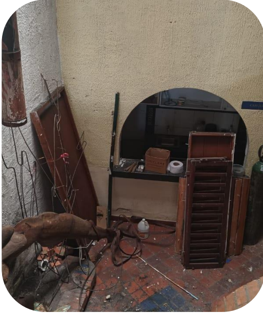
Retiro de elementos Casa de la cultura
