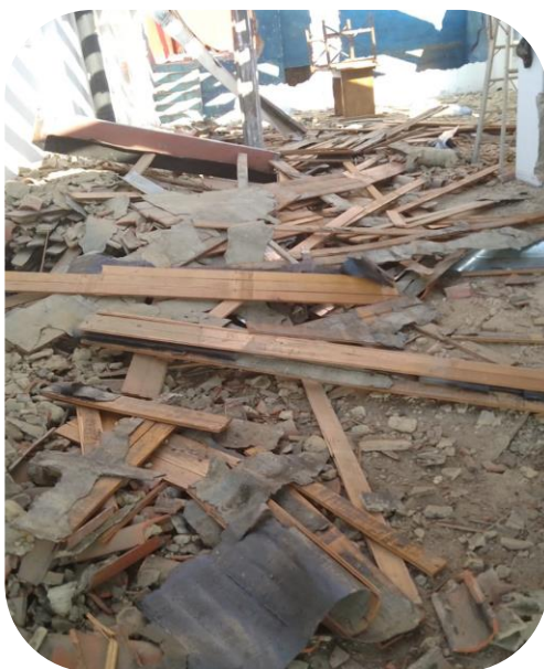
Demolición Casa de la cultura
