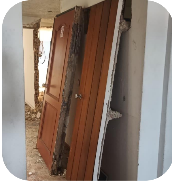
Retiro de elementos Casa de la cultura
