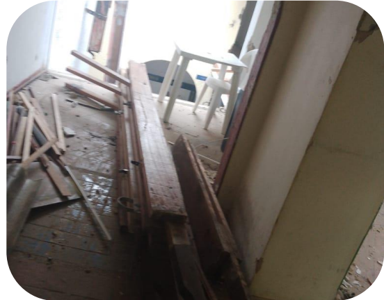
Demolición Casa de la cultura
