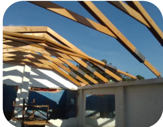
Demolición Casa de la cultura
