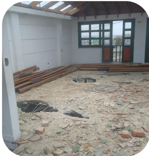
Demolición Casa de la cultura
