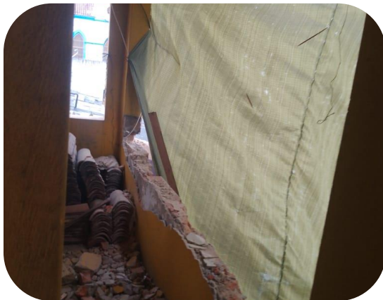
Demolición Casa de la cultura
