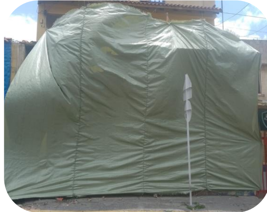
Demolición Casa de la cultura
