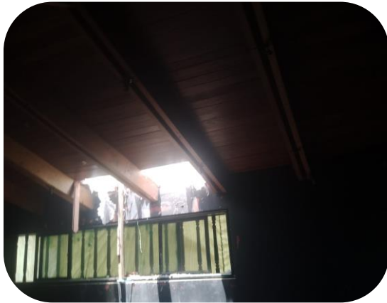
Demolición Casa de la cultura
