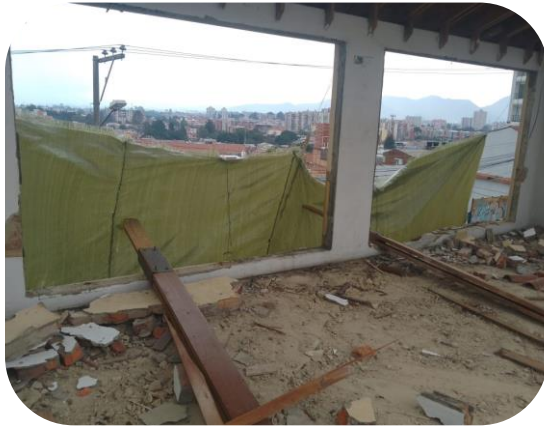
Demolición Casa de la cultura
