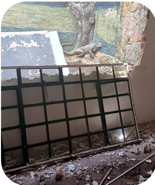
Retiro de ventaneria Casa de la cultura
