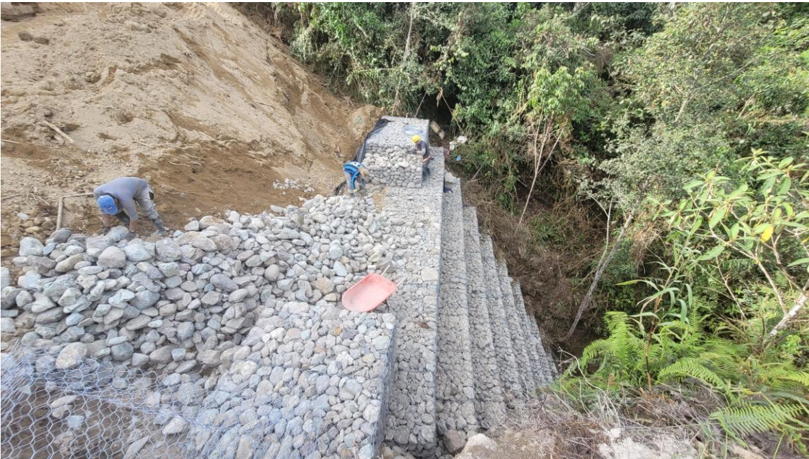
K1+600 Vía terciaria Colón – Vergel de Fátima, Municipio de Colón CONSTRUCCIÓN DE MURO DE CONTENCIÓN EN GAVIONES DE MALLA DE ACERO GALVANIZADO.
