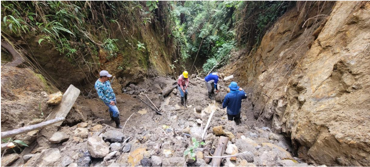
K1+600 Vía terciaria Colón – Vergel de Fátima, Municipio de Colón EXCAVACIONES A MANO PARA CIMENTACIÓN DE GAVIONES.
