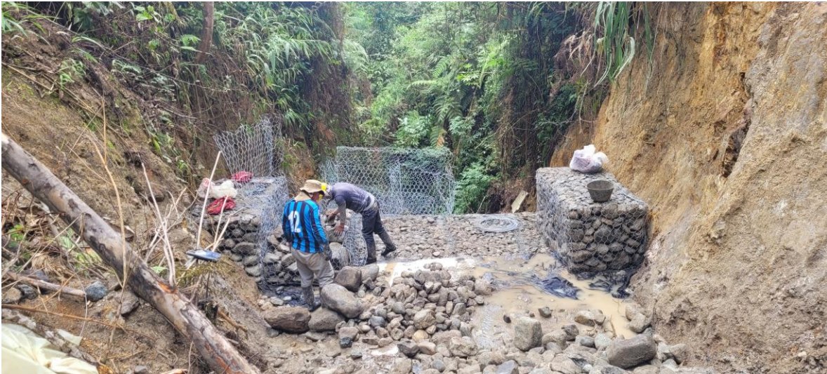
K1+600 Vía terciaria Colón – Vergel de Fátima, Municipio de Colón CONSTRUCCIÓN DE MURO DE CONTENCIÓN EN GAVIONES DE MALLA DE ACERO GALVANIZADO.
