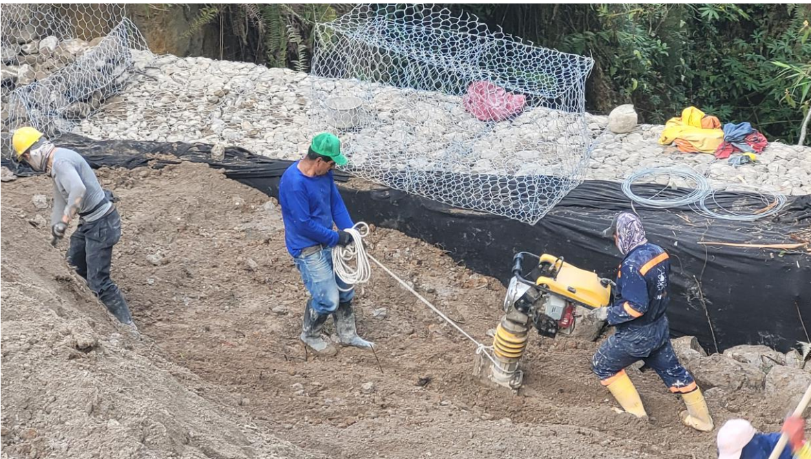
K1+600 Vía terciaria Colón – Vergel de Fátima, Municipio de Colón RELLENO PARA ESTRUCTURAS. COMPACTACIÓN MANUAL.
