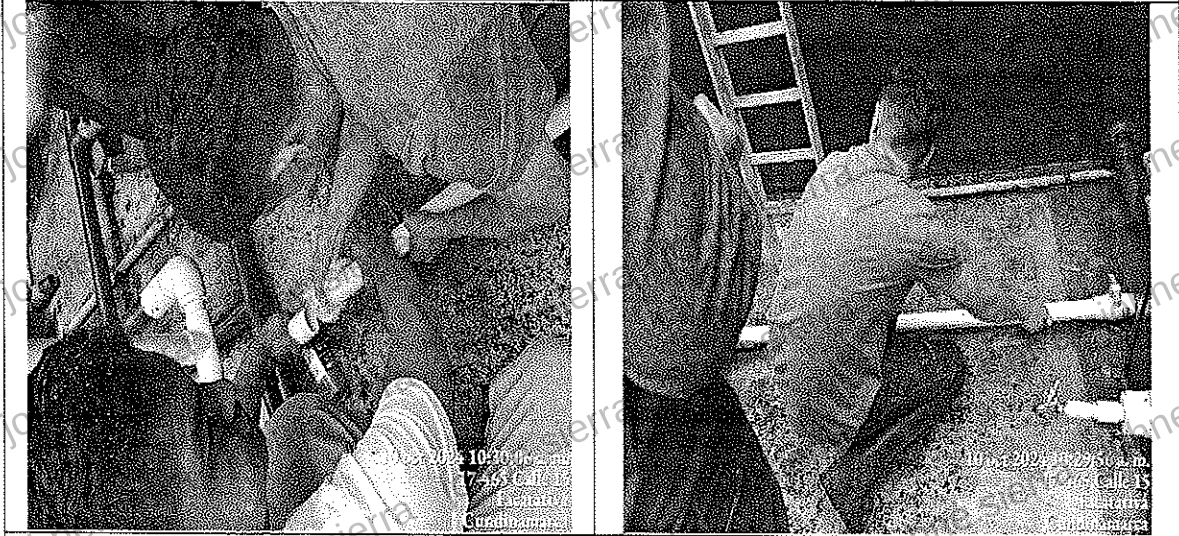
Arreglo de redes hidráulicas de la PTAP
