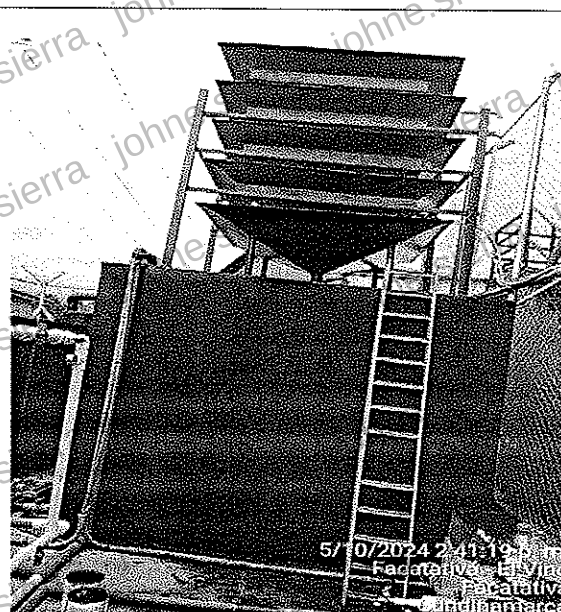
Mantenimiento de Bandejas de Aireación
