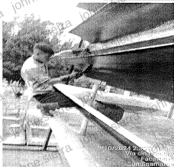
Mantenimiento de Bandejas de Aireación
