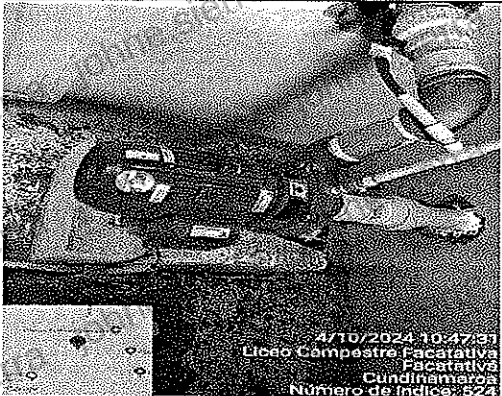
Mantenimiento de bomba de succión de agua
