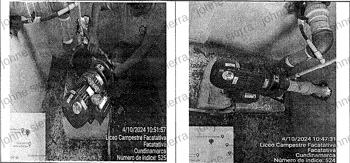
Mantenimiento de bomba de succión de agua
