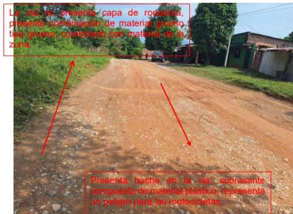
Ilustración 4. Registro fotográfico de la vía.
