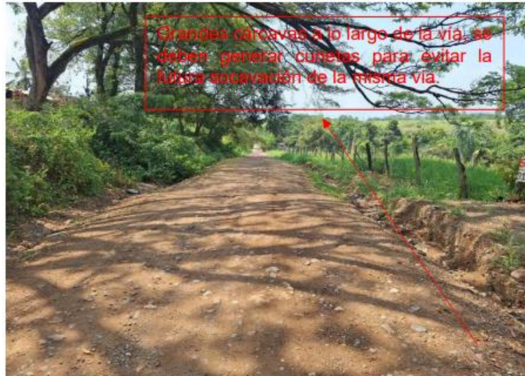
Ilustración 5: Registro fotográfico de la vía.
