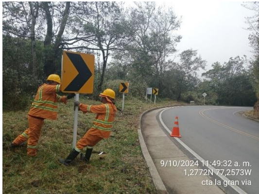
Reparación manual de señales verticales
