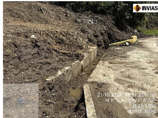
Ruta 1003 PR030+0110 Retiro de derrumbe y limpieza de obra de arte
