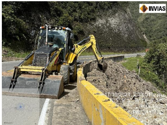
Ruta 1003 PR030+0110 Retiro de derrumbe y limpieza de obra de arte
