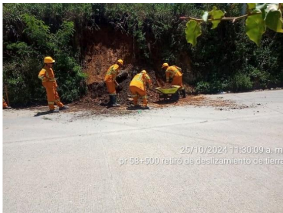
Retiro manual de derrumbes
