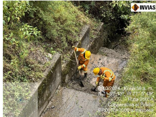
Limpieza de descole de obras de arte
