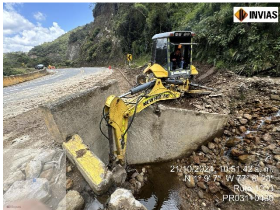
Ruta 1003 PR030+0110 Retiro de derrumbe y limpieza de obra de arte
