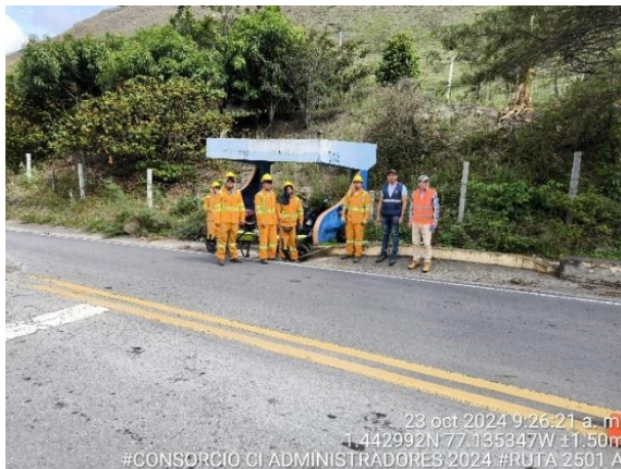
Revisión por parte de Supervisor de los trabajos adelantados por la Cooperativas de mantenimiento rutinario
