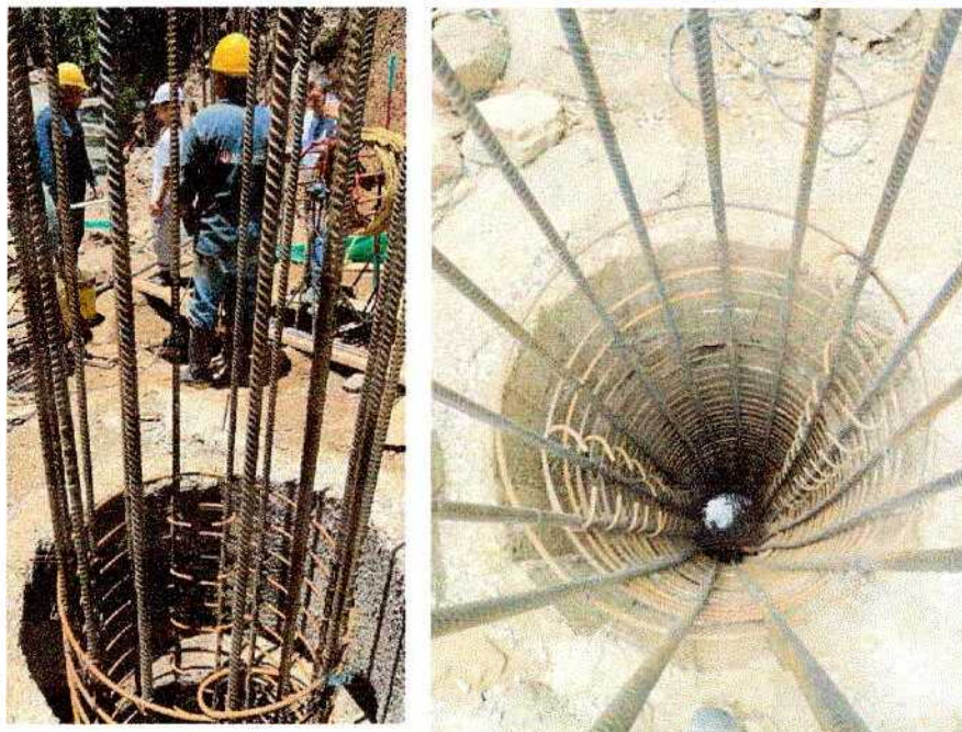
Imagen No 01. Armado de Canasta en estribo Izquierdo.
