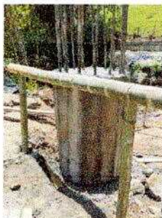
Imagen No 02. Vaciado de pilas.
