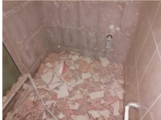
Demolición enchape baños
