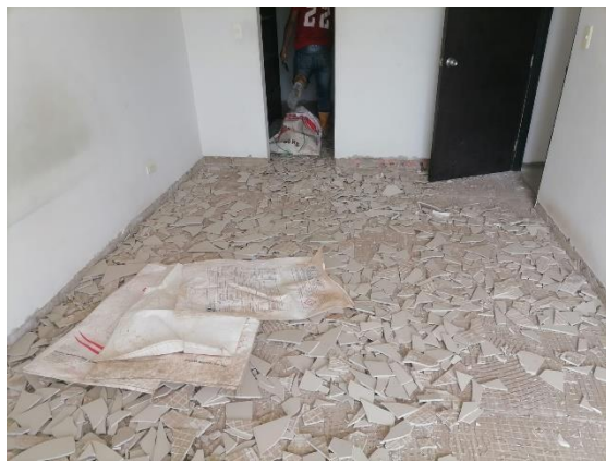
Demolición enchape piso.
