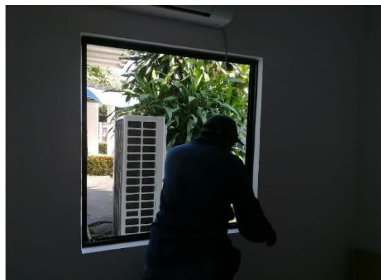
Instalacion ventanas en aluminio
