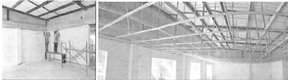
Figuras 13: Estructura soporte de cielos rasos. Fuente: interventoría i.c.i. inspecciones y construcciones industriales Ltda. Contrato 0042-ARC-CBNL01-202
