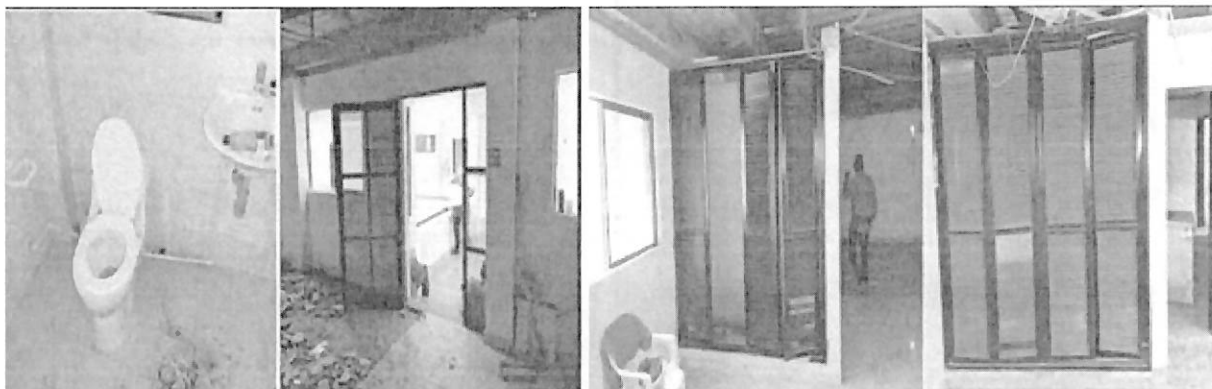
Figuras 6: elementos que necesariamente hay que desmontar por las condiciones encontradas
