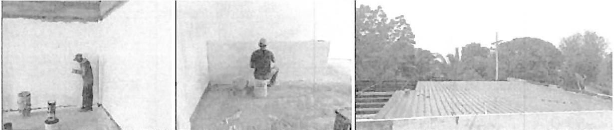
Figuras 12: Estucado Interno de muros y Suministro e instalación de Cubierta en teja EcoroofUPVC 2.5mm. Fuente: interventoría i.c.i. inspecciones y construcciones industriales Ltda. Contrato 0042-ARC-CBNL01-202
