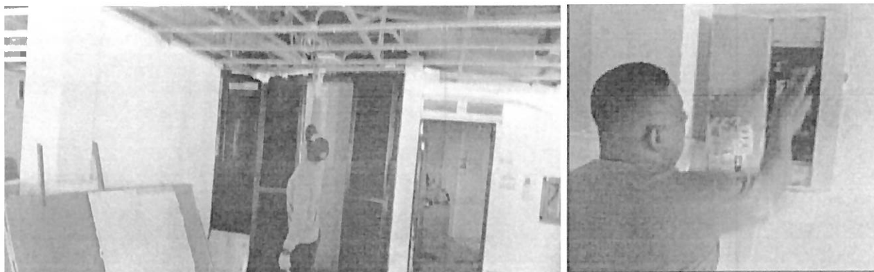
Figuras 5: Desmante de cableado y desenergización del sistema
