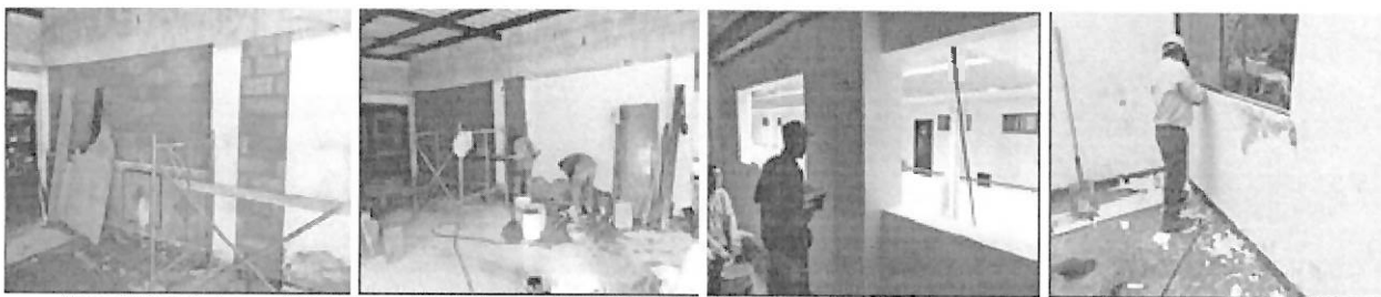
Figuras 11: Levante de muros, Pañete impermeabilizado, Reconstrucción de Vanos y Escarificado. Fuente: interventoría i.c.i. inspecciones y construcciones industriales Ltda. Contrato 0042-ARC-CBNL01-202
