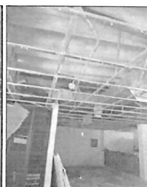
Figuras 4: desmonte de cielo raso y estructuras de soporte. Se inician las actividades de desmonte del cielo raso, estructuras y acopio de material en las áreas autorizadas por la institución Fuente: interventoría i.c.i. inspecciones y construcciones industriales Ltda. Contrato 0042-ARC-CBNL01-202
