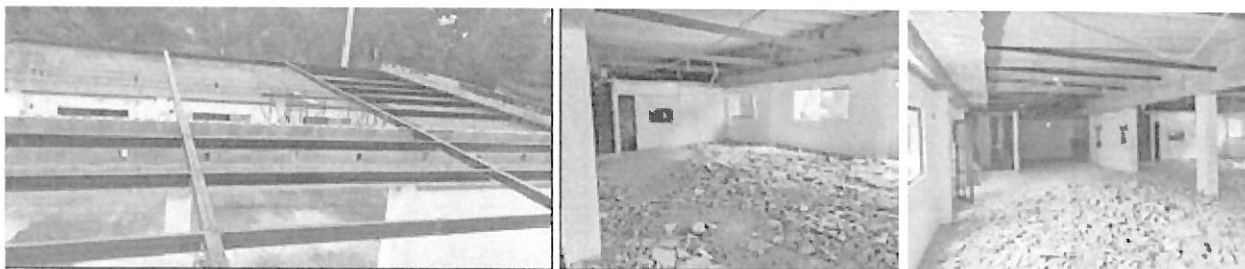
Figuras 9: Suministro e instalación de estructura metálica para soporte de cubierta, Demolición de pisos y plantillas de piso Fuente: interventoría i.c.i. inspecciones y construcciones industriales Ltda. Contrato 0042-ARC-CBNL01-202
