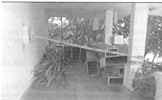
Figuras 4: desmonte de cielo raso y estructuras de soporte. Se inician las actividades de desmonte del cielo raso, estructuras y acopio de material en las áreas autorizadas por la institución Fuente: interventoría i.c.i. inspecciones y construcciones industriales Ltda. Contrato 0042-ARC-CBNL01-202
