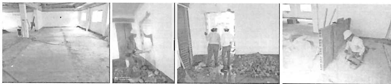
Figuras 10: Plantilla impermeabilizada, demolición de muros, levante de muros. Fuente: interventoría i.c.i. inspecciones y construcciones industriales Ltda. Contrato 0042-ARC-CBNL01-202
