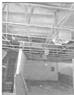
Figuras 4: desmonte de cielo raso y estructuras de soporte. Se inician las actividades de desmonte del cielo raso, estructuras y acopio de material en las áreas autorizadas por la institución Fuente: interventoría i.c.i. inspecciones y construcciones industriales Ltda. Contrato 0042-ARC-CBNL01-202
