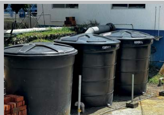
INSTALACIÓN DEL SISTEMA DE COAGULANTE LÍQUIDO EN LA PLANTA DE TRATAMIENTO
