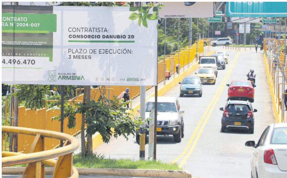
Se espera un reforzamiento que garantice la vida útil de esta estructura.
