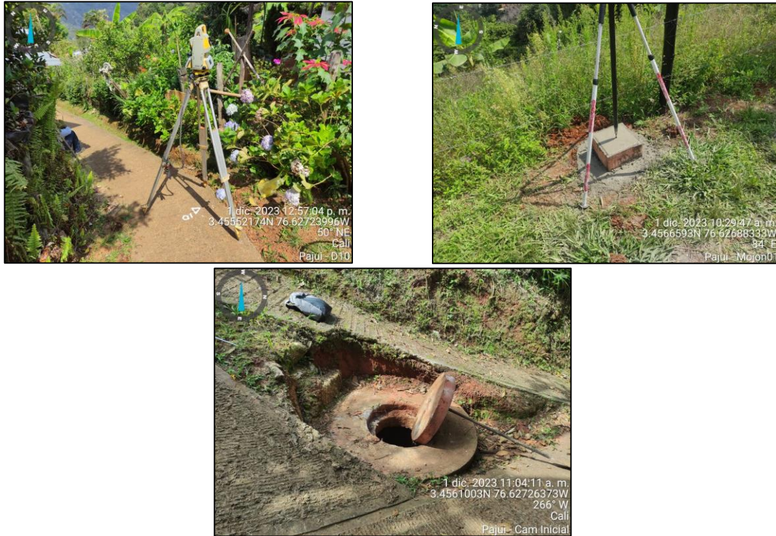
Figura 1-4. Actividades de monumentación y levantamiento topográfico del contrato No. 4182.010.26.1.540-2023
