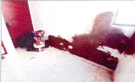
Aplicación de estuco en pared– apto 102 – Blq Tauramena
