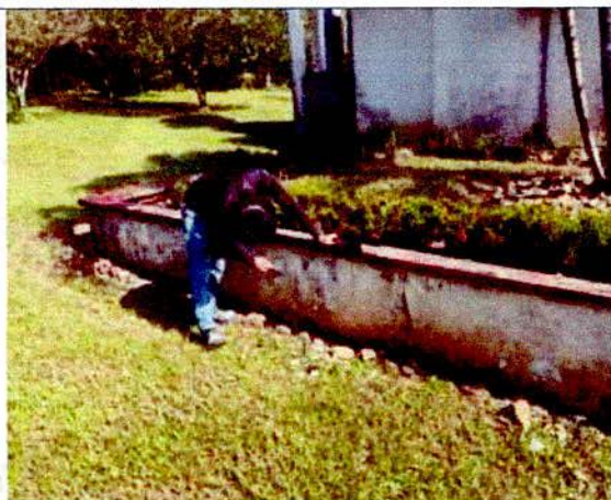
SE INICIA RETIRANDO PINTURA DETERIORADA
