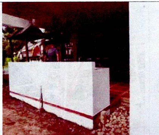
MANTENIMIENTO DE PINTURA CORREGIDO
