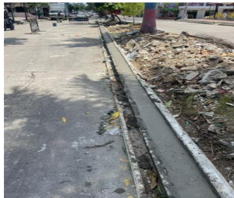
Construcción de bordillos en concreto: Carrera 8 entre 42B y 42
