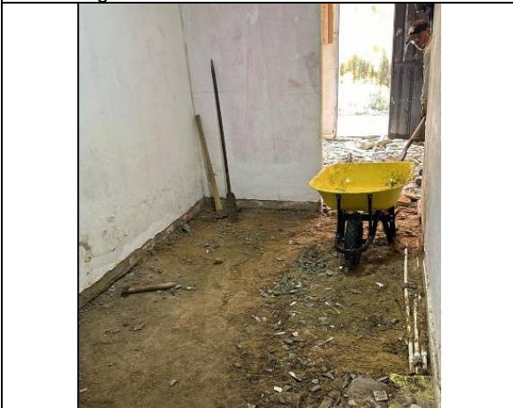
Imagen 3: demolición de plantilla
