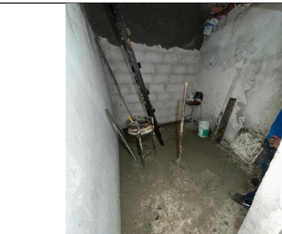
Imagen 10: pañete de muros
