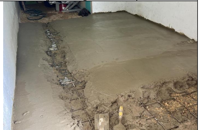
Imagen 4: plantilla de piso con malla electrosoldada.
