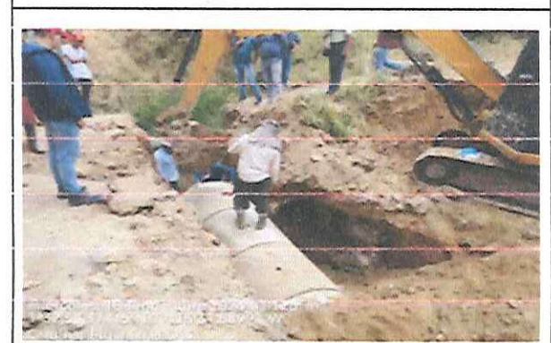
Foto 6: Instalación de tubería
