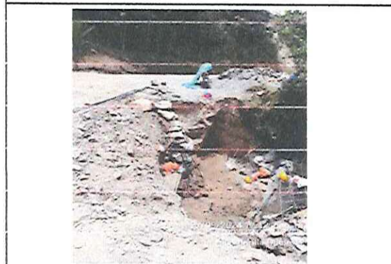
Foto3: Excavación y perfilado cimentación
