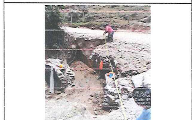
Foto4: Excavación y perfilado cimentación aletas alcantarilla
