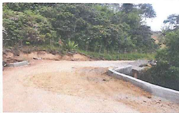
Foto4: relleno alcantarilla muro
