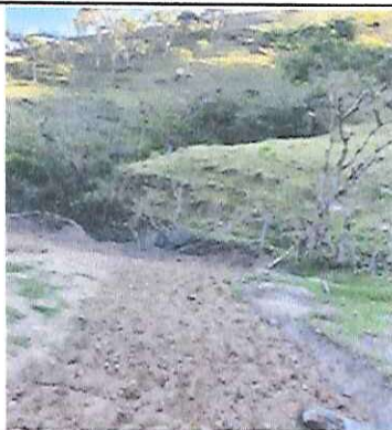
Foto3: relleno tubería alcantarilla
