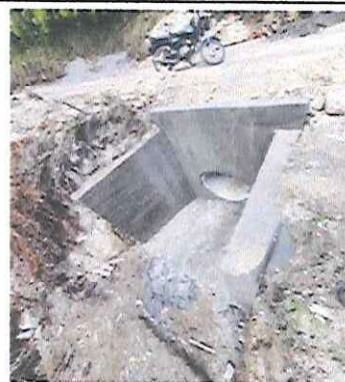
Foto2: aletas descole alcantarilla
