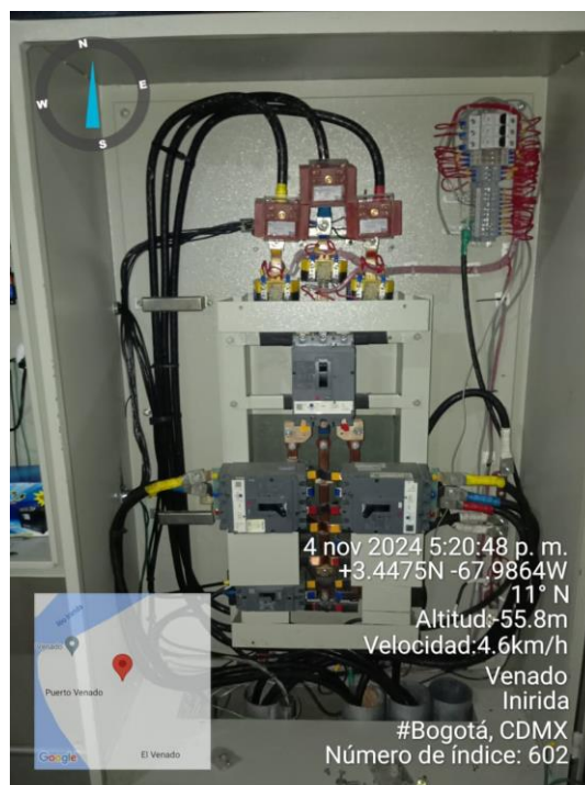
Imagen 4. Salida de potencia Sistema Híbrido
