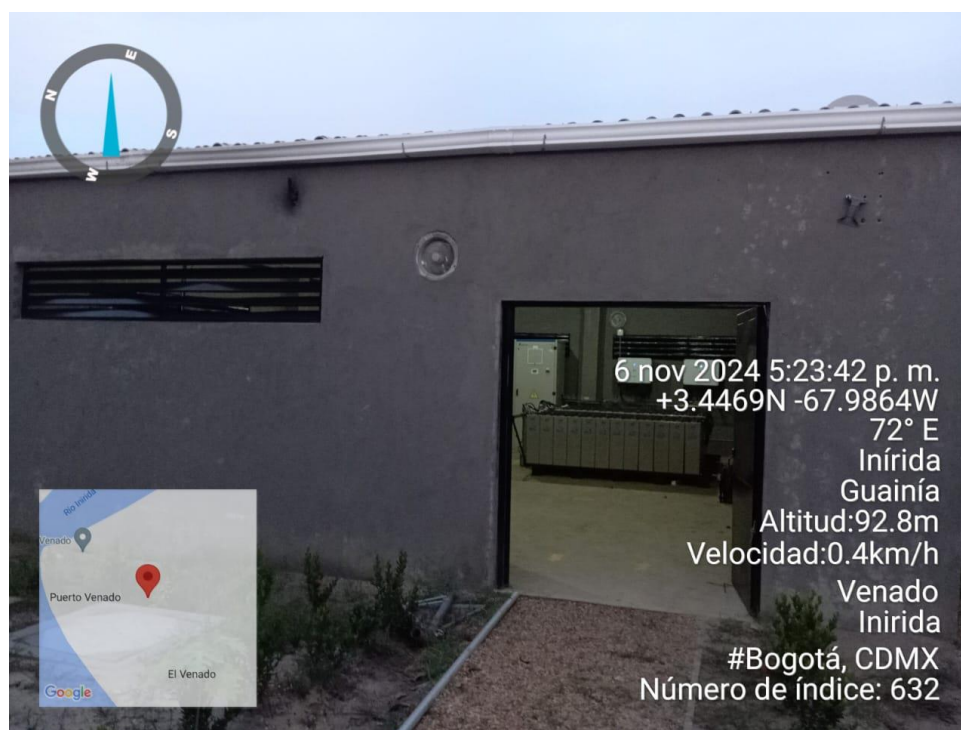
Imagen 2. Instalación física de la central de generación
