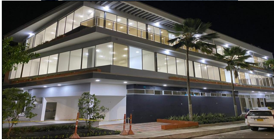
Fachada sede Judicial Espacios Urbanos Zomac S.A.S
