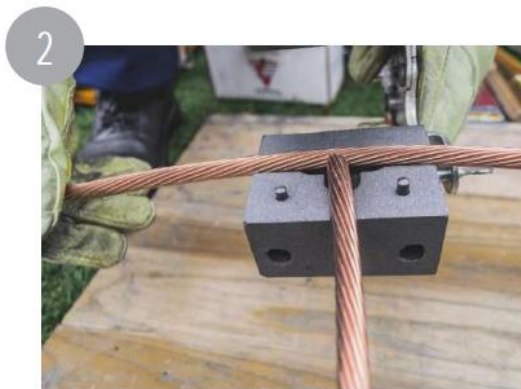
2 Coloque los conductores limpios y secos en el molde de grafito.
