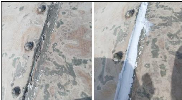
Avances 82.6% en sellado de juntas.
