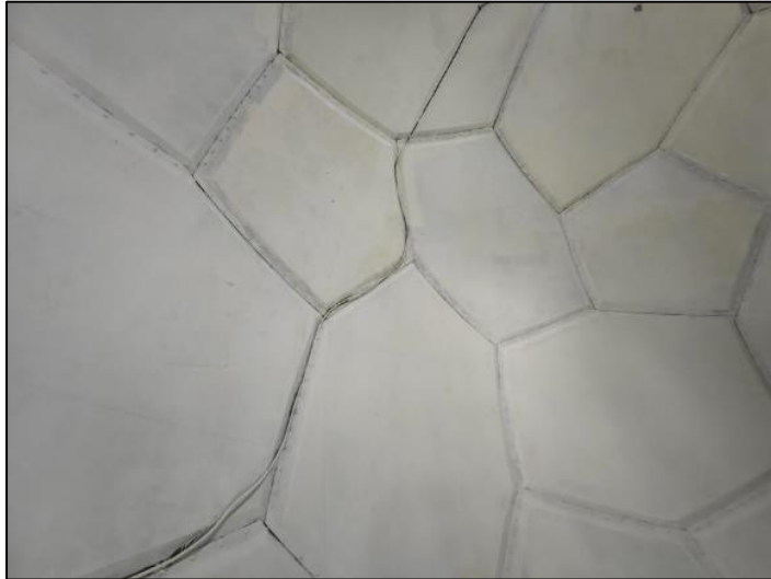
Avances 100% en limpieza y pintado cúpula interna.
