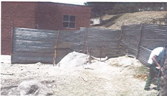
DEPOSITAMIENTO DE CERRAMIENTO PERIMETRO
