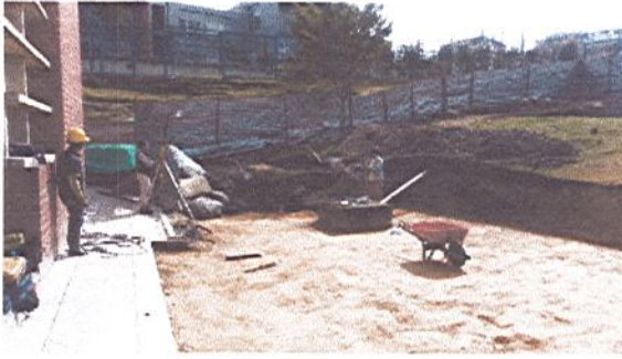
Continúa con actividades de RECEPO B-400 compactado
