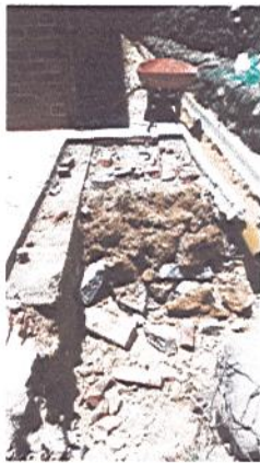
DÉMOLICIÓN DE CONCRETO PARA LA UBICACIÓN DE LA TRAMPA DE GRASAS
