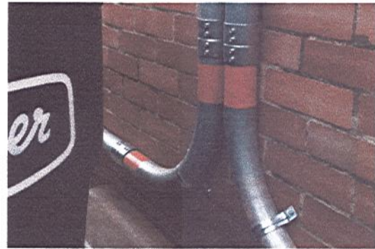
SEÑALIZACIÓN DE LAS TUBERÍAS ELÉCTRICAS Y ANCLAJE DE INTERMEDIO DE AISLAMIENTO
