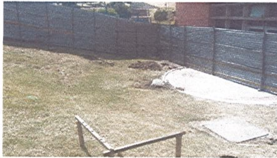
SE REALIZAN ACTIVIDADES DE CERRAMIENTO ALREDEDOR A INTERVENIR
