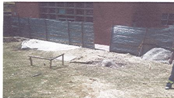
SE HACE REPLANTEO Y LOCACIÓN
