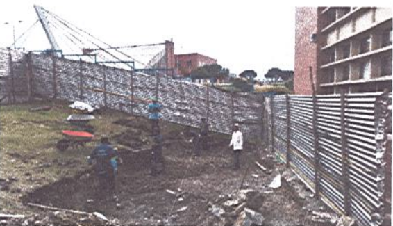
ACTIVIDADES DE EXCAVACIONES EN LA CASA PARA LA PLAZA DE CONTRAPISO E-25
