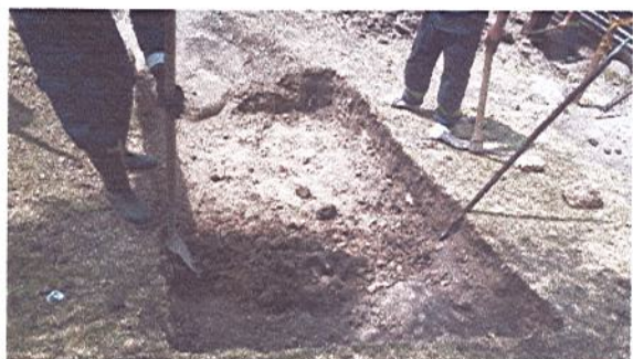
SE REALIZAN ACTIVIDADES DE EXCAVACIONES PARA LA PLAZA DE GEODOS
