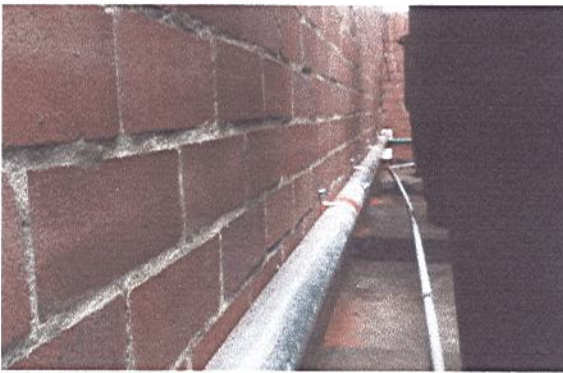
Activaciones tuberías EMT 3" \phi
