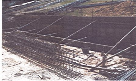
ARMADO DE VIGAS DE PLACA DE CONCRETO
