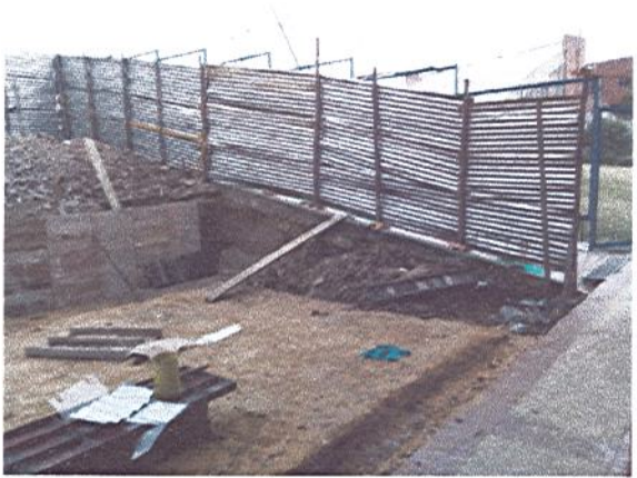
REVISIÓN DEL CERCA MIENTO DEBIDO A LA AMPLIACIÓN DEL MURO DE CONTENCIÓN
