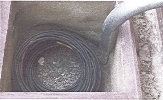
RESERVA DE 10 MTS DE CABLE 1/0 HOLICIDAD X DES
