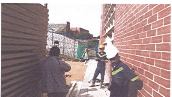
SE REALIZAN ACTIVIDADES DE DESARROLLO COMPACTADO PARA MEJORAMIENTO
