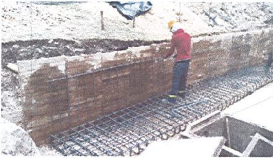
ENCUADRO DEL MURO DE CONTENCIÓN Y ARMADO DE HIERRO DE LA ZALZA
