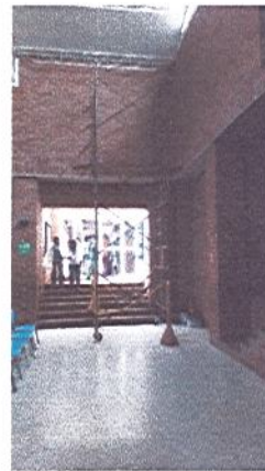
Utilización de ANCLAJES PARA LA INSTALACIÓN DE TUBERÍAS ELÉCTRICAS
