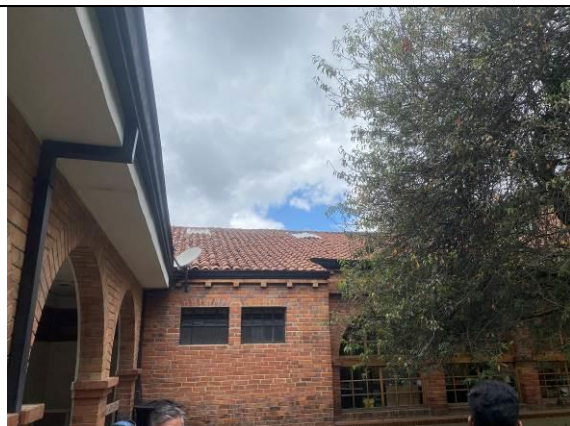
Fotografía 15. Vista de la edificación emplazada al costado noroccidental del predio.
