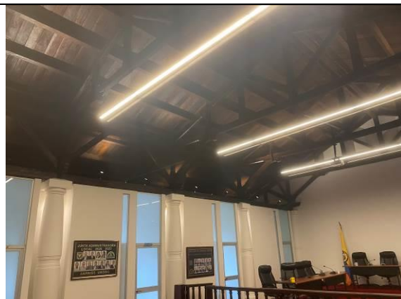
Fotografía 4. Columnas en concreto sobre las que se apoya la cercha en madera, sin evidencia de daños.
