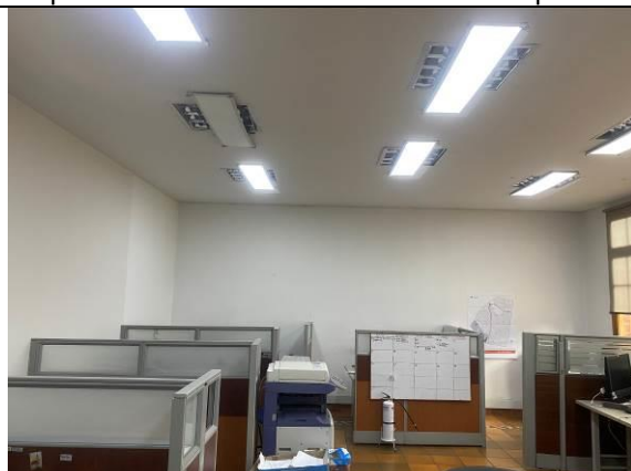
Fotografía 17. Interior de las oficinas sin evidencia de daños en muros, cielorraso y piso.
