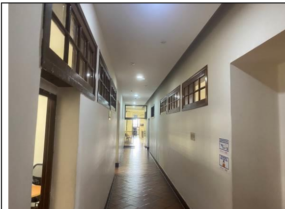
Fotografía 9. Espacios visitados en el primer nivel de la edificación central, sin evidencia de daños.
