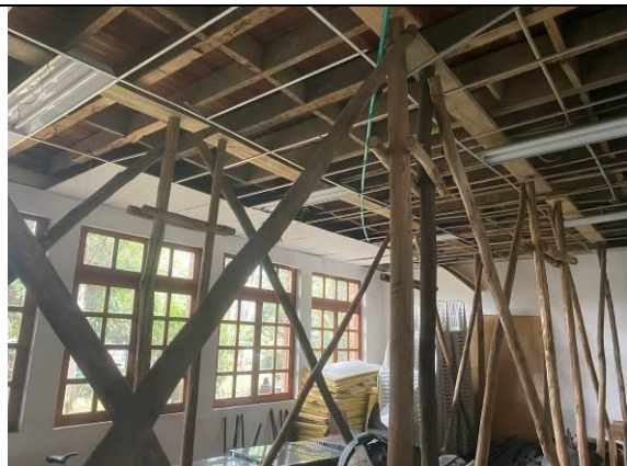
Fotografía 11. Apuntalamientos instalados al interior de las oficinas para sostener la cercha en madera que sostiene la cubierta.
