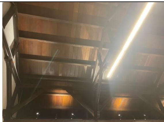
Fotografía 3. Cercha en madera que sostiene la cubierta sin evidencia de daños.
