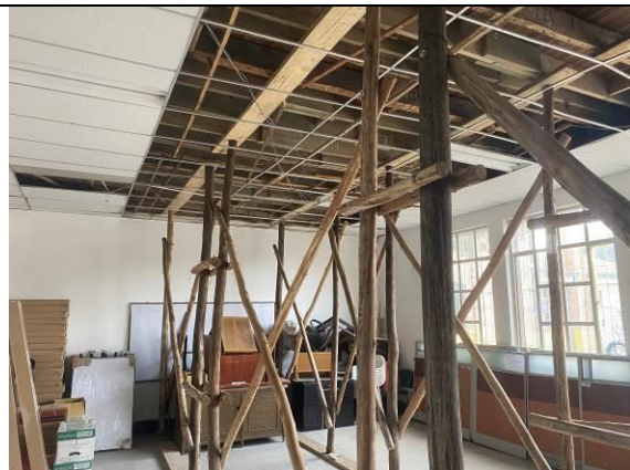
Fotografía 12. Apuntalamientos instalados al interior de las oficinas para sostener la cercha en madera que sostiene la cubierta.
