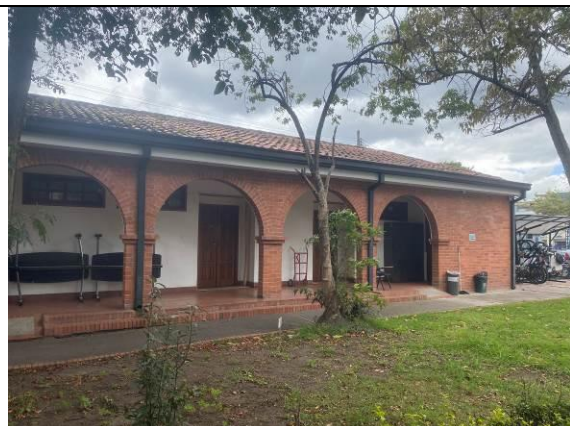
Fotografía 10. Edificación emplazada al costado suroriental del predio.
