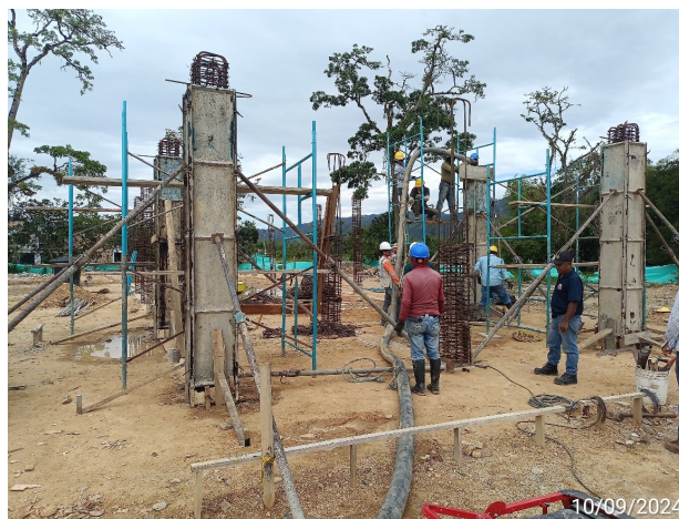
Fundida de concreto para columnas de 40x40 Módulo Biblioteca
