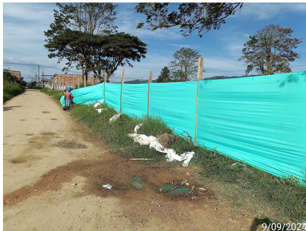
Mantenimiento Cerramiento Provisional de Proyecto
