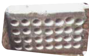
Ducto EB revestido en concreto
