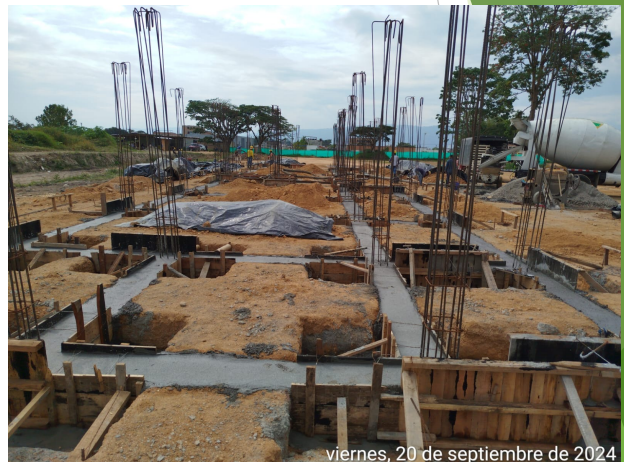
Fundida de Concreto para Vigas de Cimentación - Módulo Sala de Profesores
