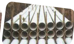
Ducto DB o TDP instalado directamente en el terreno
