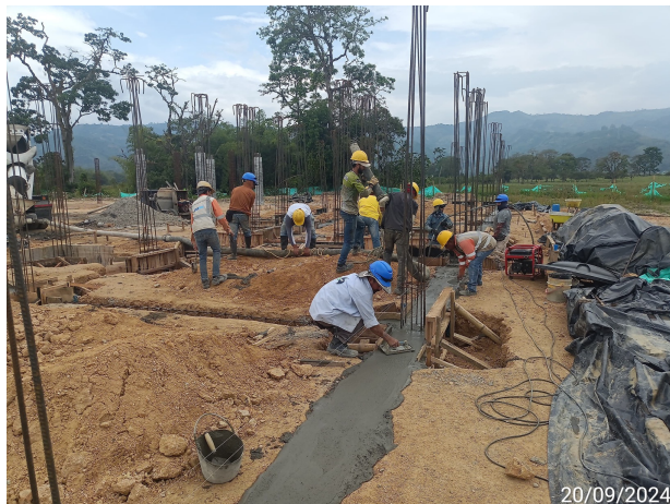
Fundida de Concreto para Vigas de Cimentación - Módulo Sala de Profesores
