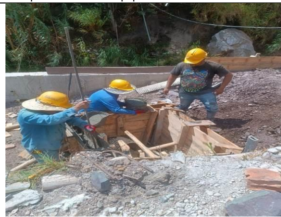
Construcción de caja de inspección
