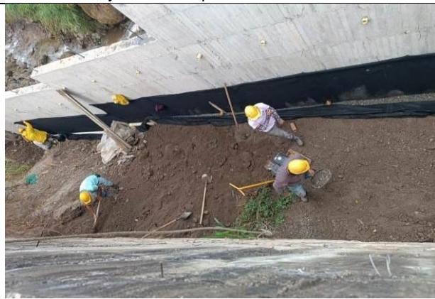
Instalación de filtro
