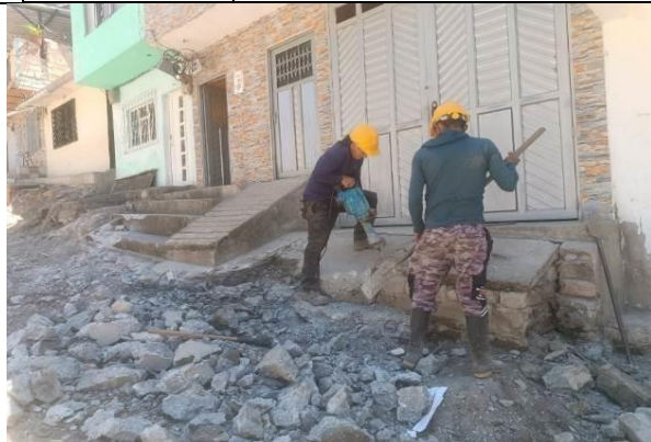
Demolición de Andenes y pavimento
