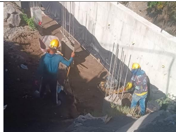
Compactación con equipo manual
