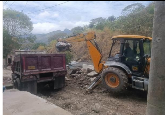
Retiro de material sobrante
