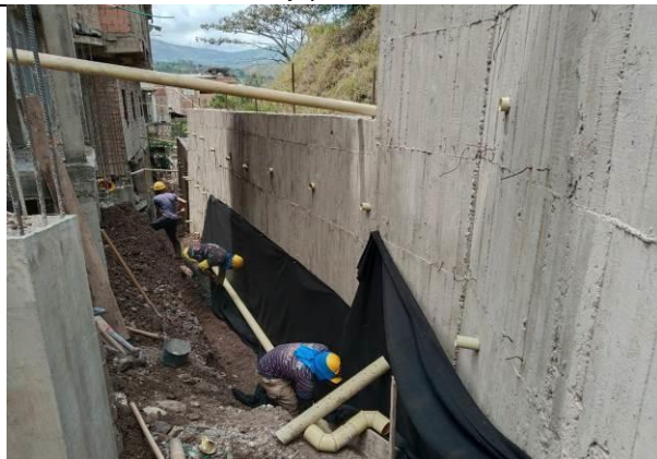
Instalación de drenaje filtros
