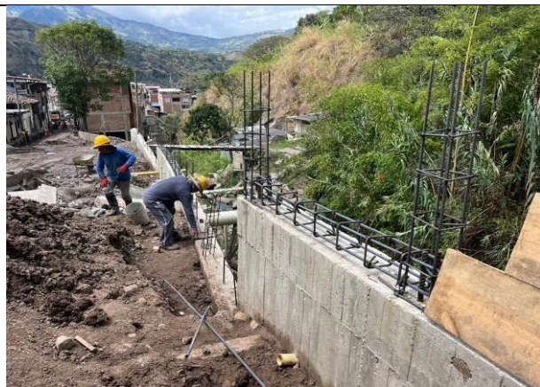
Fundición de vigas y columnetas del cerramiento
