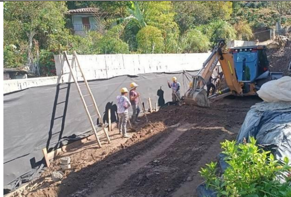
Relleno con ayuda de maquinaria
