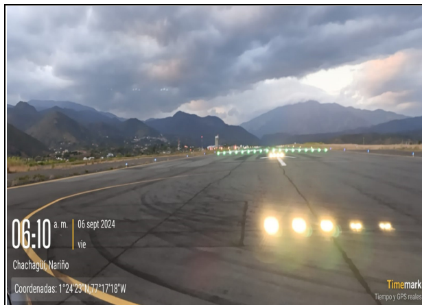
Fot. No. 6 - Recorrido diario para verificar el funcionamiento de las luces del sistema de ayudas visuales del aeropuerto.
