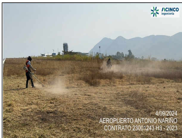
Fot. No. 1 - Rocería manual en la zona de seguridad cabecera 0-2 del aeropuerto.
