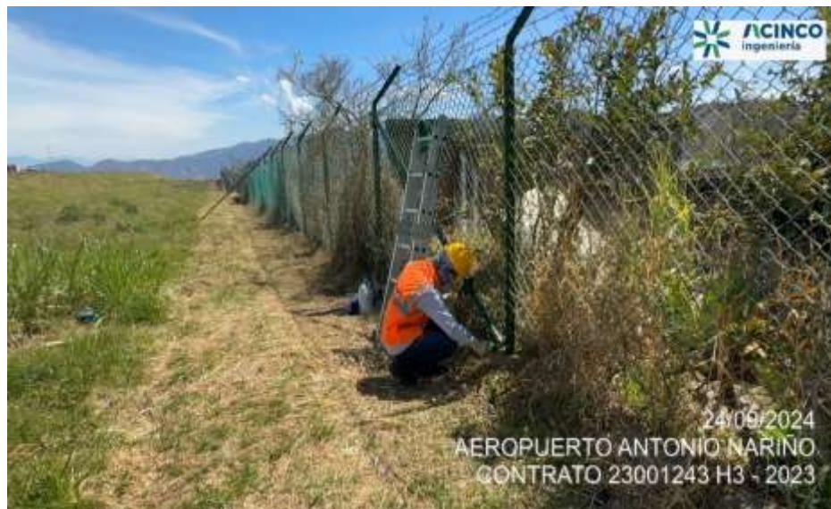
Fotografía No.: 10 Aplicación de pintura para el mantenimiento y limpieza del cerramiento en el sector nor oriental del aeropuerto.
