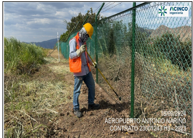
Fot. No. 5 - Aplicación de pintura para el mantenimiento y limpieza del cerramiento en el sector nor oriental del aeropuerto.
