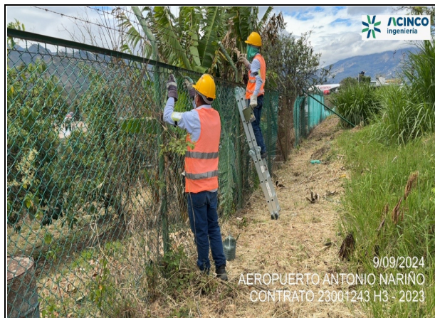
Fot. No. 5 - Aplicación de pintura para el mantenimiento y limpieza del cerramiento en el sector nor oriental del aeropuerto.
