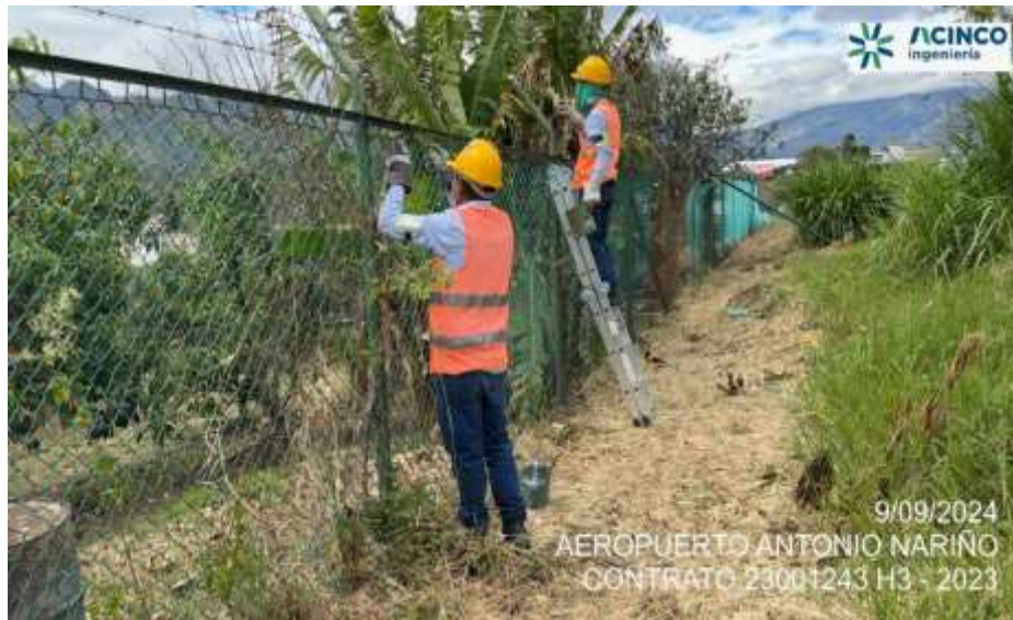
Fotografía No.: 5 Aplicación de pintura para el mantenimiento y limpieza del cerramiento en el sector nor oriental del aeropuerto.
