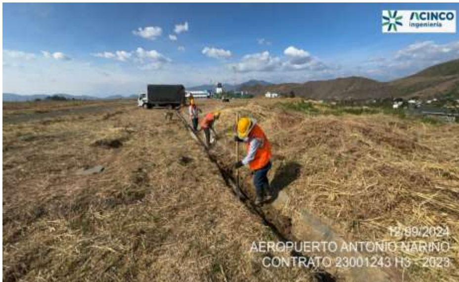
Fotografía No.: 4 Mantenimiento y limpieza de los canales en el sector sur oriental del aeropuerto.
