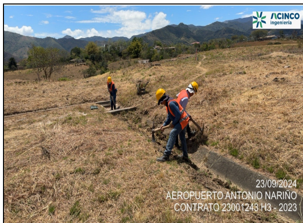
Fot. No. 3 - Mantenimiento y limpieza de los canales en el sector sur oriental del aeropuerto.
