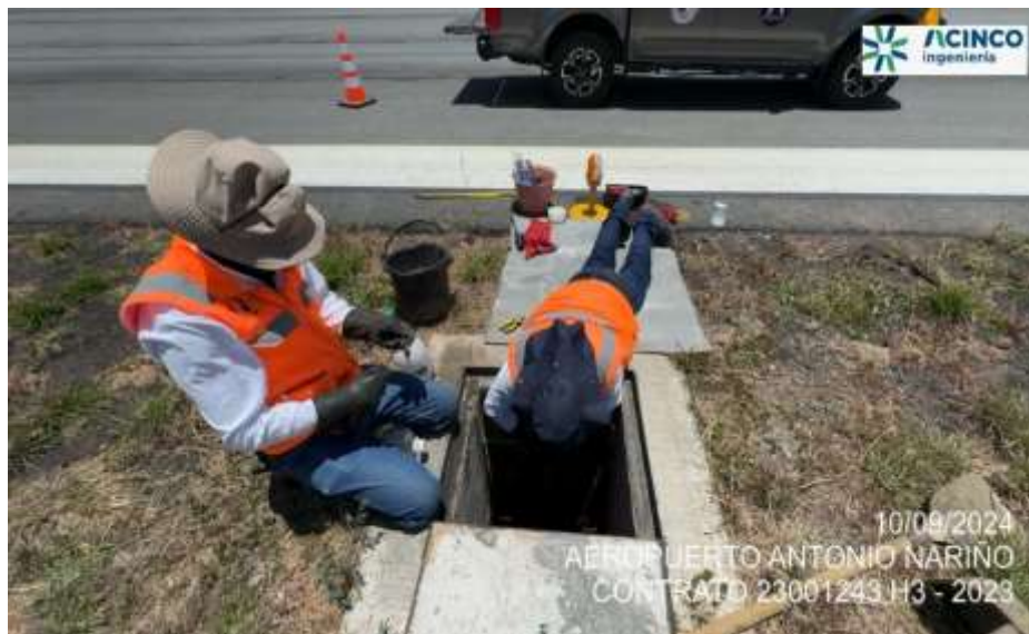
Fotografía No.: 6 Mantenimiento de cajas de inspección de luces de borde de pista cabecera 2-0 del aeropuerto.
