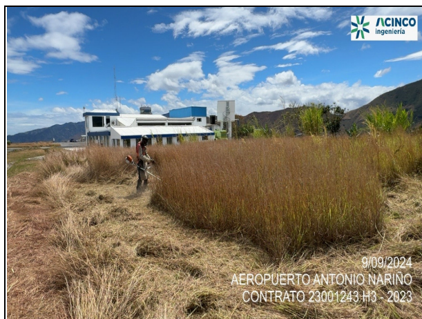
Fot. No. 1 - Rocería manual en sector sur oriental del aeropuerto detrás de la estación de bomberos.
