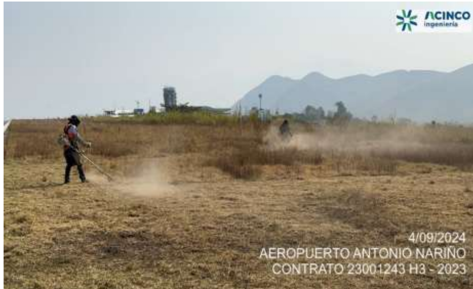
Fotografía No.: 1 Rocería manual en la zona de seguridad cabecera 0-2 del aeropuerto.
