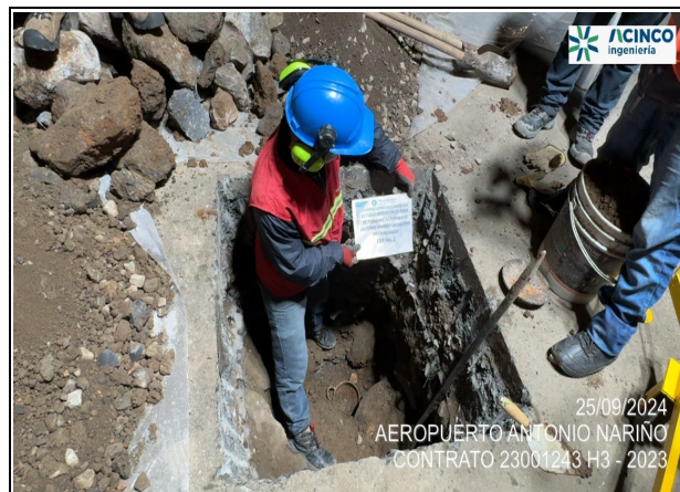
Fot. No. 6 - Apique No. 1 y toma de muestra para CBR, en la zona de parqueo No. 2 de la plataforma del aeropuerto.
