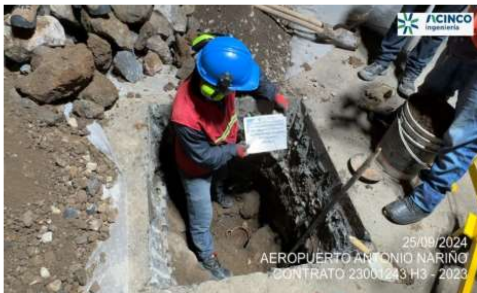
Fotografía No.: 12 Apique No. 1 y toma de muestra para CBR, en la zona de parqueo No. 2 de la plataforma del aeropuerto.
