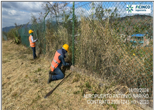
Fot. No. 6 - Retiro de maleza en la parte externa para mantenimiento del cerramiento en el sector nor oriental del aeropuerto.
