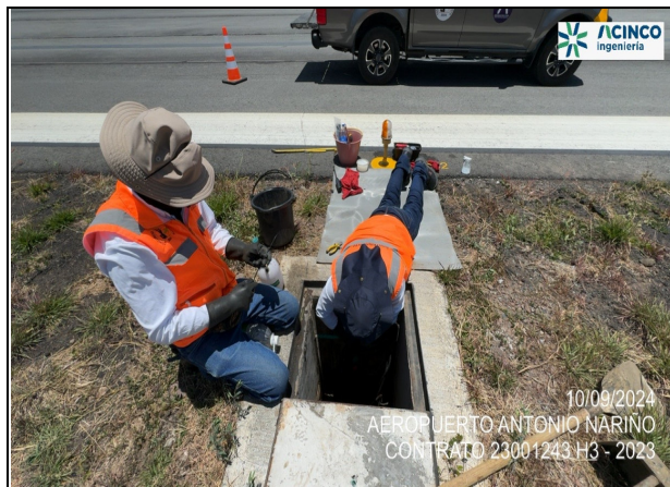
Fot. No. 6 - Mantenimiento de cajas de inspección de luces de borde de pista cabecera 2-0 del aeropuerto.
