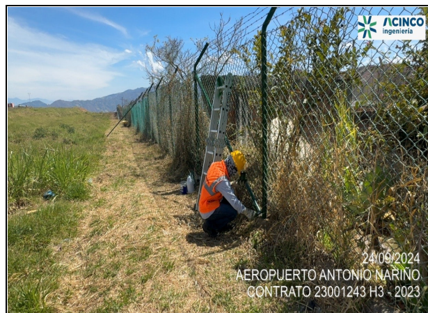
Fot. No. 4 - Aplicación de pintura para el mantenimiento y limpieza del cerramiento en el sector nor oriental del aeropuerto.
