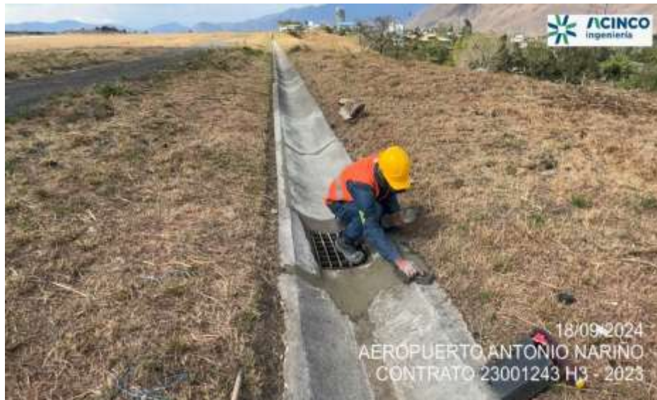
Fotografía No.: 7 Mantenimiento y limpieza de los canales en el sector sur oriental del aeropuerto.
