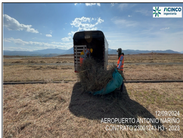
Fot. No. 2 - Recolección de material vegetal en sector sur oriental del aeropuerto.
