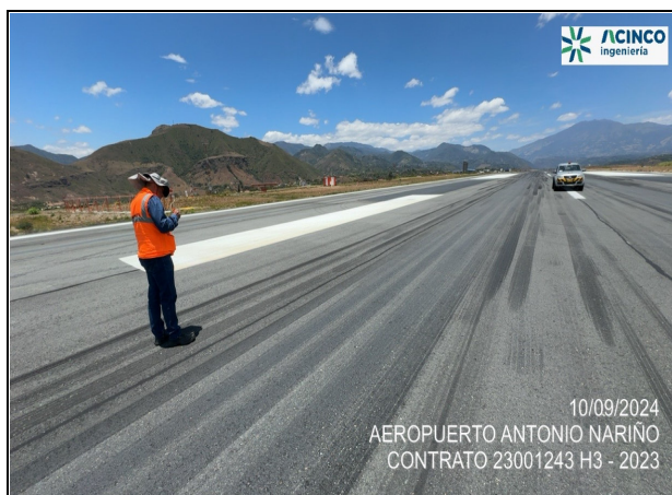
Fot. No. 4 - Recorrido para marcación de áreas de intervención para descontaminación por caucho en la pista del aeropuerto.
