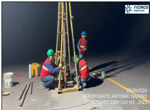
Fot. No. 5 - Sonde No. 3 en la zona de parqueo No. 3 de la plataforma del aeropuerto.
