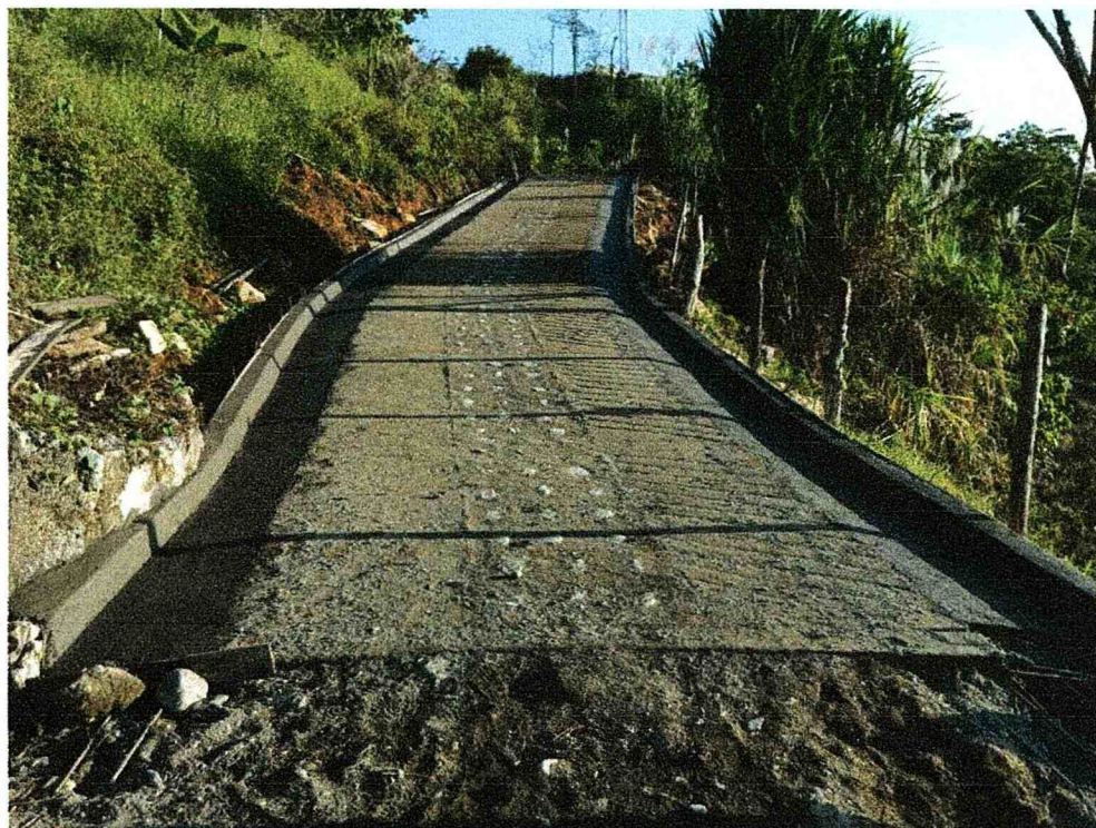
Fotografías 1, 2, 3 y 4. Seguimiento a Construcción de Placa Huella, Vereda la Ventana.
