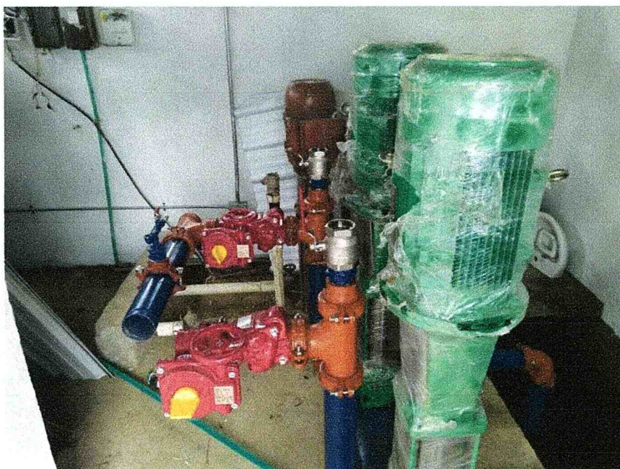
Fotografías 9, 10, 11 y 12. Seguimiento a Obra "Construcción del Plan Maestro del Corregimiento de Aquitania"
