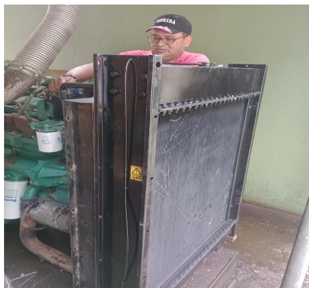
Foto 6. Mantenimiento radiador
