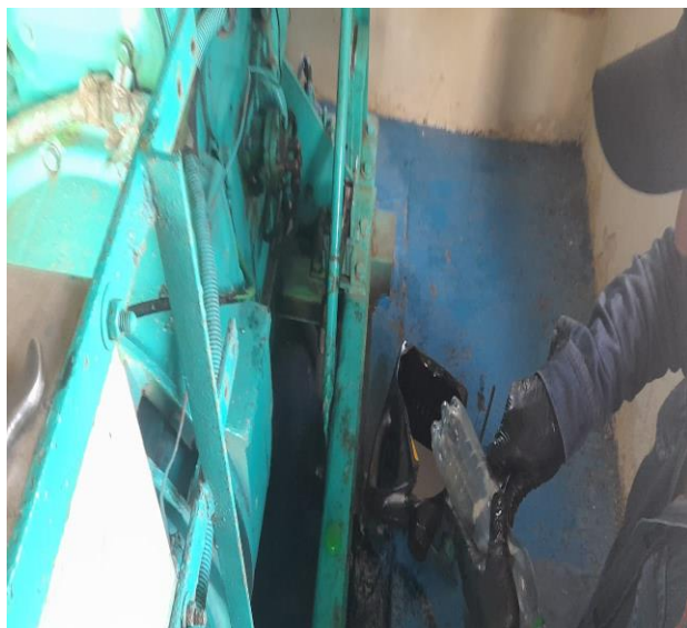
Foto 1. Suministro Y Cambio De Sensor De Nivel De Combustible
