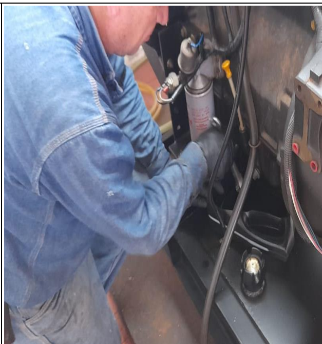
Foto Suministro Y Cambio De Sensor De Combustible.
