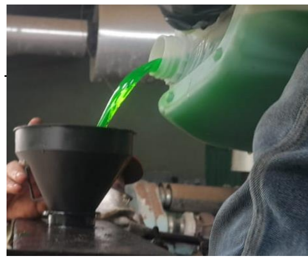
Foto 10. Suministro y cambio de líquido refrigerante
