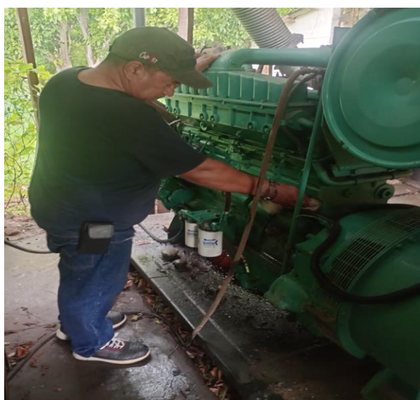
Foto 2. Suministro Y cambio filtro de Combustible
