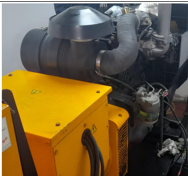
Foto 8. Suministro y cambio de filtro de aire filtro secador
