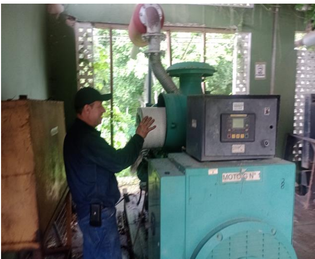
Foto 4. Suministro Y cambio filtro de aire
