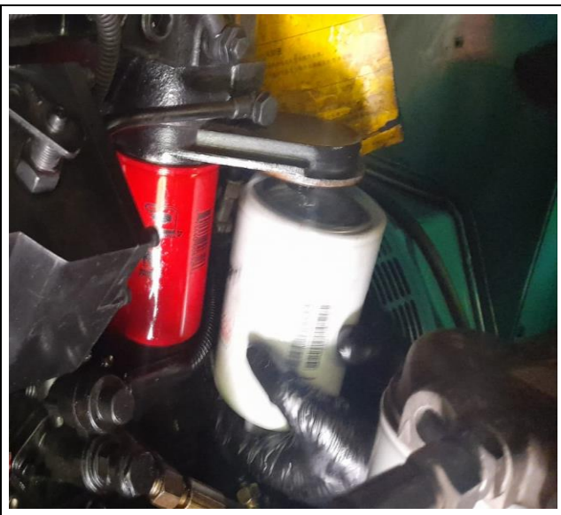
Foto 2. Suministro Y Cambio De Combustible
