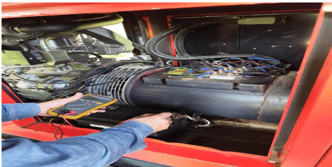
Foto 3. Prueba de aislamiento
