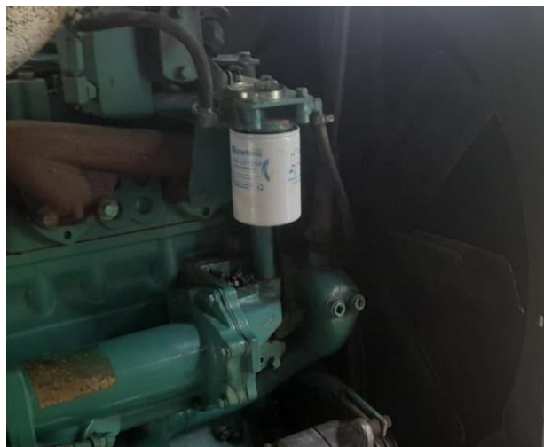
Foto 3. Suministro Y cambio filtro de agua
