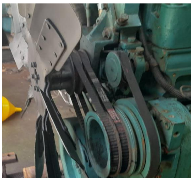
Foto 10. Cambio correa de ventilador
