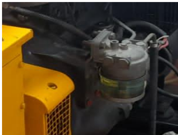
Foto 4. Suministro y cambio de filtro de Combustible.
