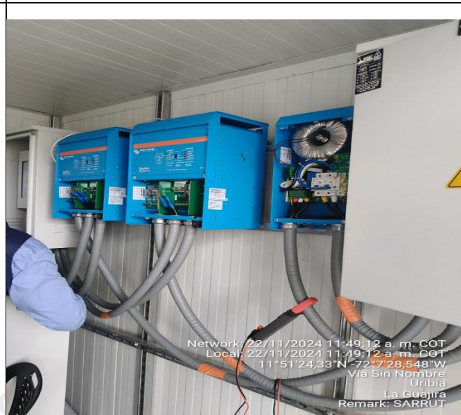
Instalación de cable de red de baja tension
