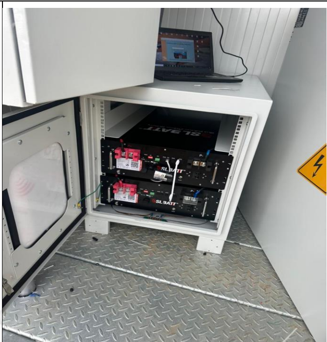
Instalación de baterías
