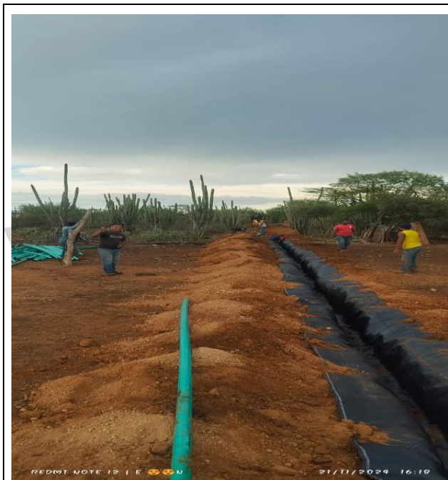
Instalación de geotextil
