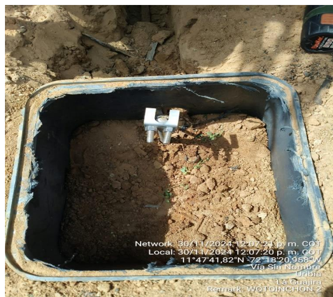
Instalación de inversores
