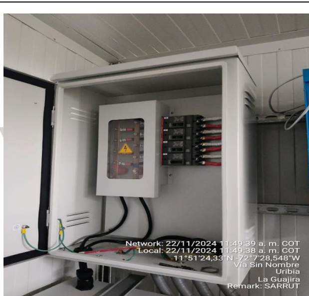
Instalacion de caja de inspección
