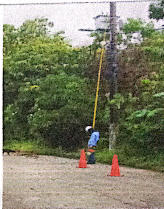
Mantenimiento red de fibra óptica hacia Centro de Convivencia.
